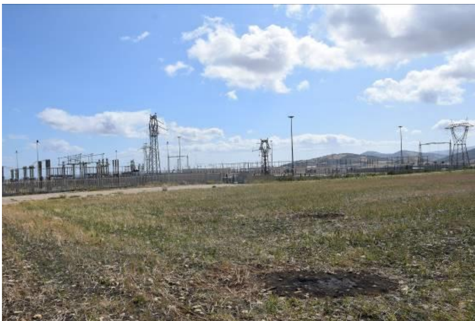
Figura 12 – Vista dell'area di realizzazione dell'ampliamento della sezione 150 kV della SE RTN 150/380 kV Troia
