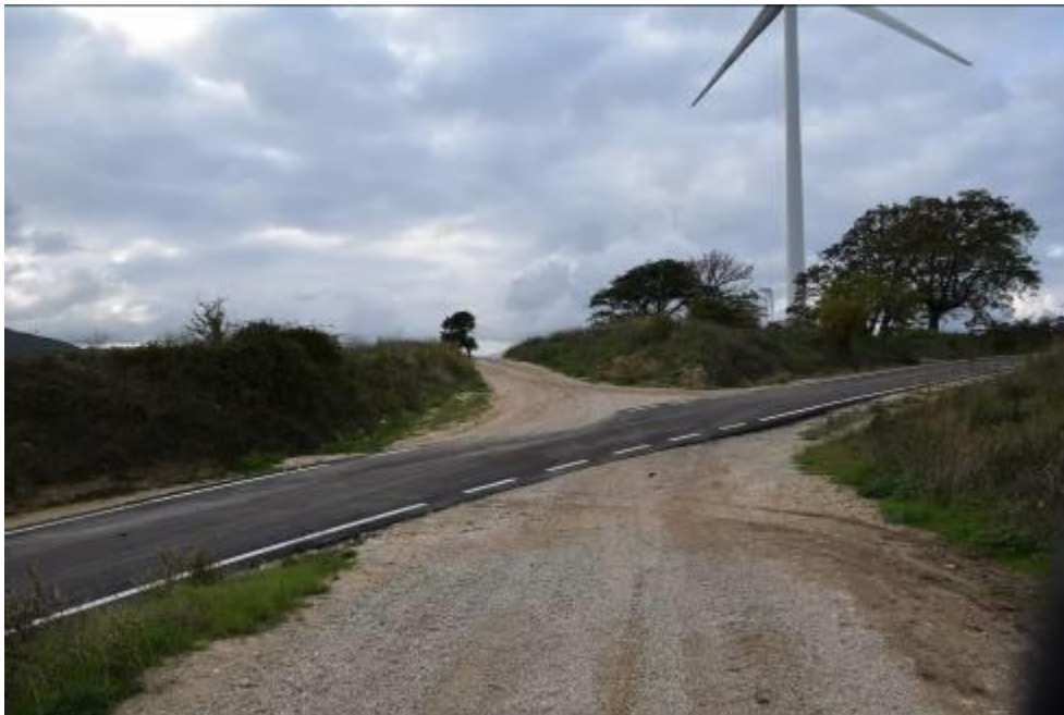
Figura 7 - Vista della viabilità interessata dal cavidotto MT in corrispondenza dell'incrocio con la strada a valenza paesaggistica "Strada di bonifica S. Lorenzo".
