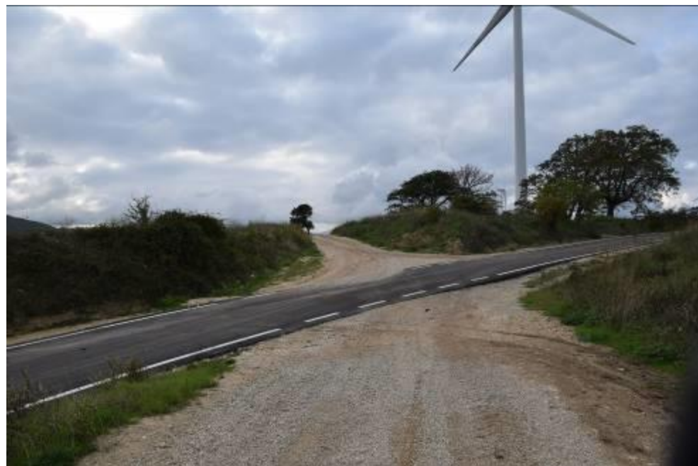
Figura 5 - Vista della viabilità interessata dal cavidotto MT in corrispondenza dell'incrocio con la strada a valenza paesaggistica "Strada di bonifica S. Lorenzo".
