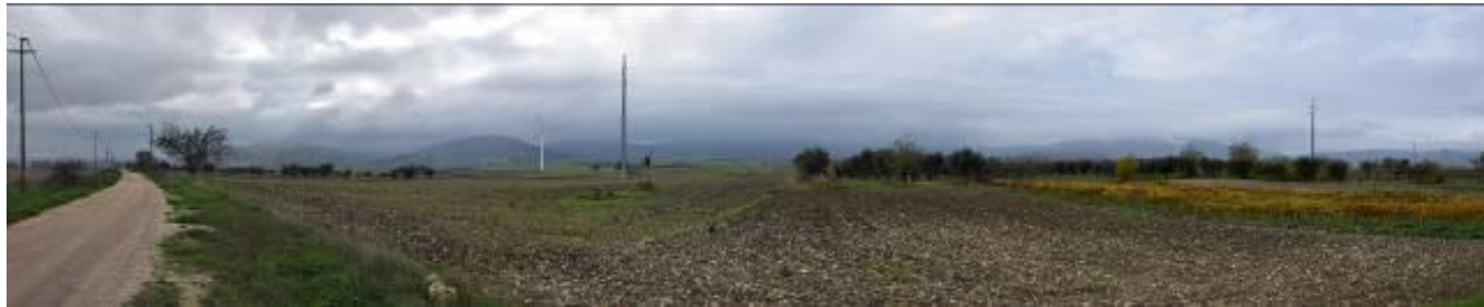
Figura 8 – Vista dell'area di realizzazione della Stazione Elettrica di utenza
