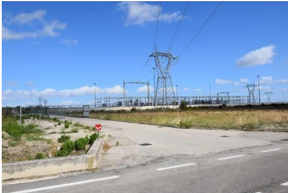
Figura 9 – Vista della SE RTN 150/380 kV Troia
