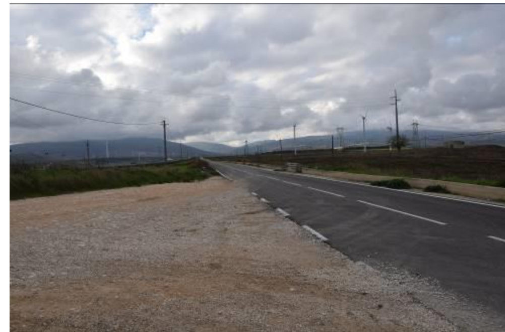
Figura 7 – Vista della viabilità interessata dal cavidotto AT in prossimità dell'incrocio tra Via Titolone e la Strada comunale Ignazia
