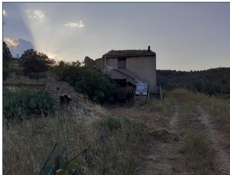
Figura 18- Fabbricato diruto F.10 p.lla 17 _CR03 Comune di Cropani
