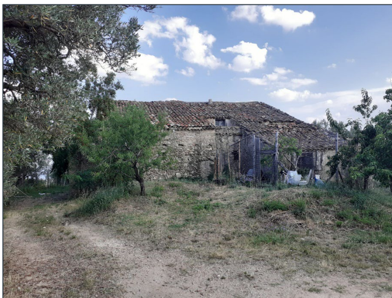
Figura 16- Fabbricato rurale F.8 p.Ila 3 _CR02 Comune di Cropani
