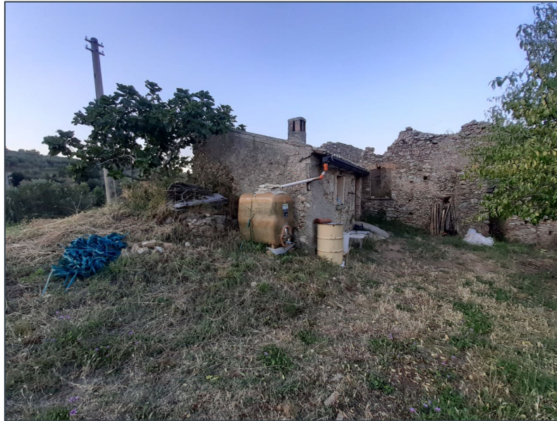
Figura 17- Fabbricato diruto F.10 p.lla 11 _CR03 Comune di Cropani
