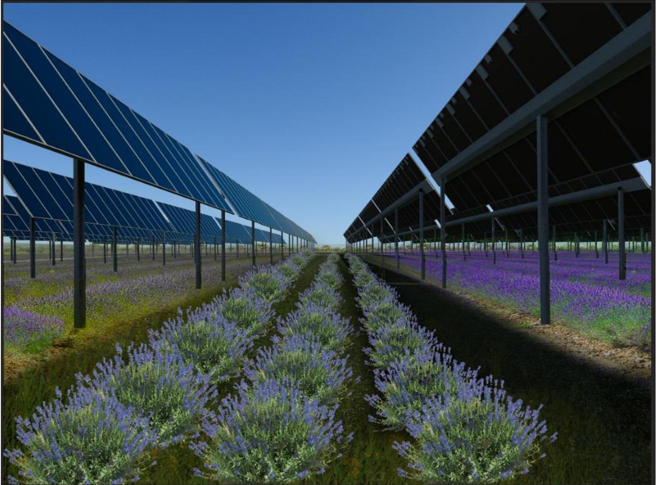
*Figura 16 – Fotosimulazione della soluzione adottata con tracker alto monoassiale e distanza tra le file di moduli pari a 5,5 m, in presenza di lavanda*
