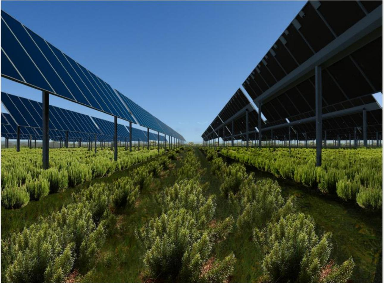
*Figura 18 – Fotosimulazione della soluzione adottata con tracker alto monoassiale e distanza tra le file di moduli pari a 5,5 m, in presenza di rosmarino*
