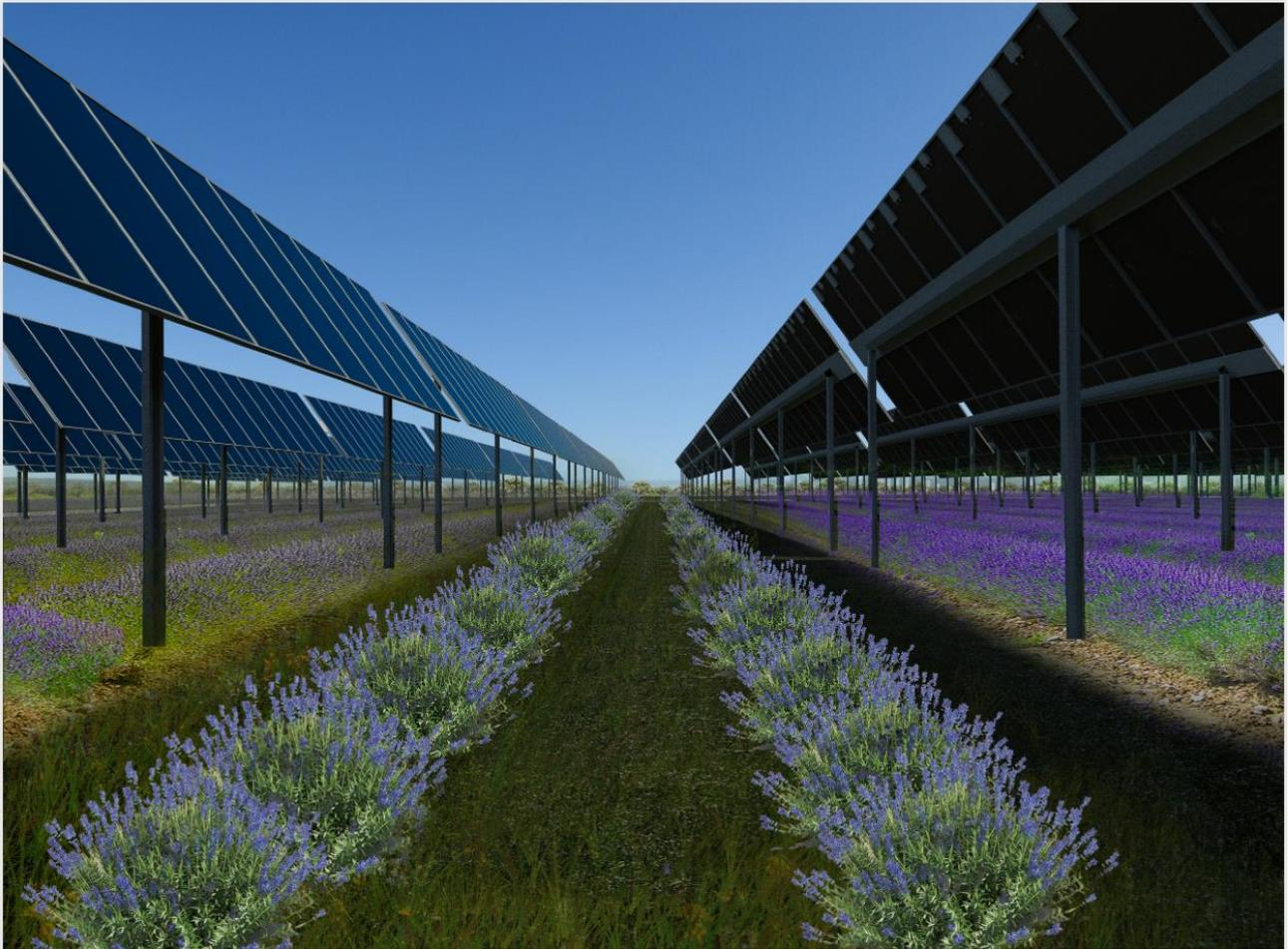
*Figura 17 – Fotosimulazione della soluzione adottata con tracker alto monoassiale e distanza tra le file di moduli pari a 5,5 m, in presenza di lavandino*
