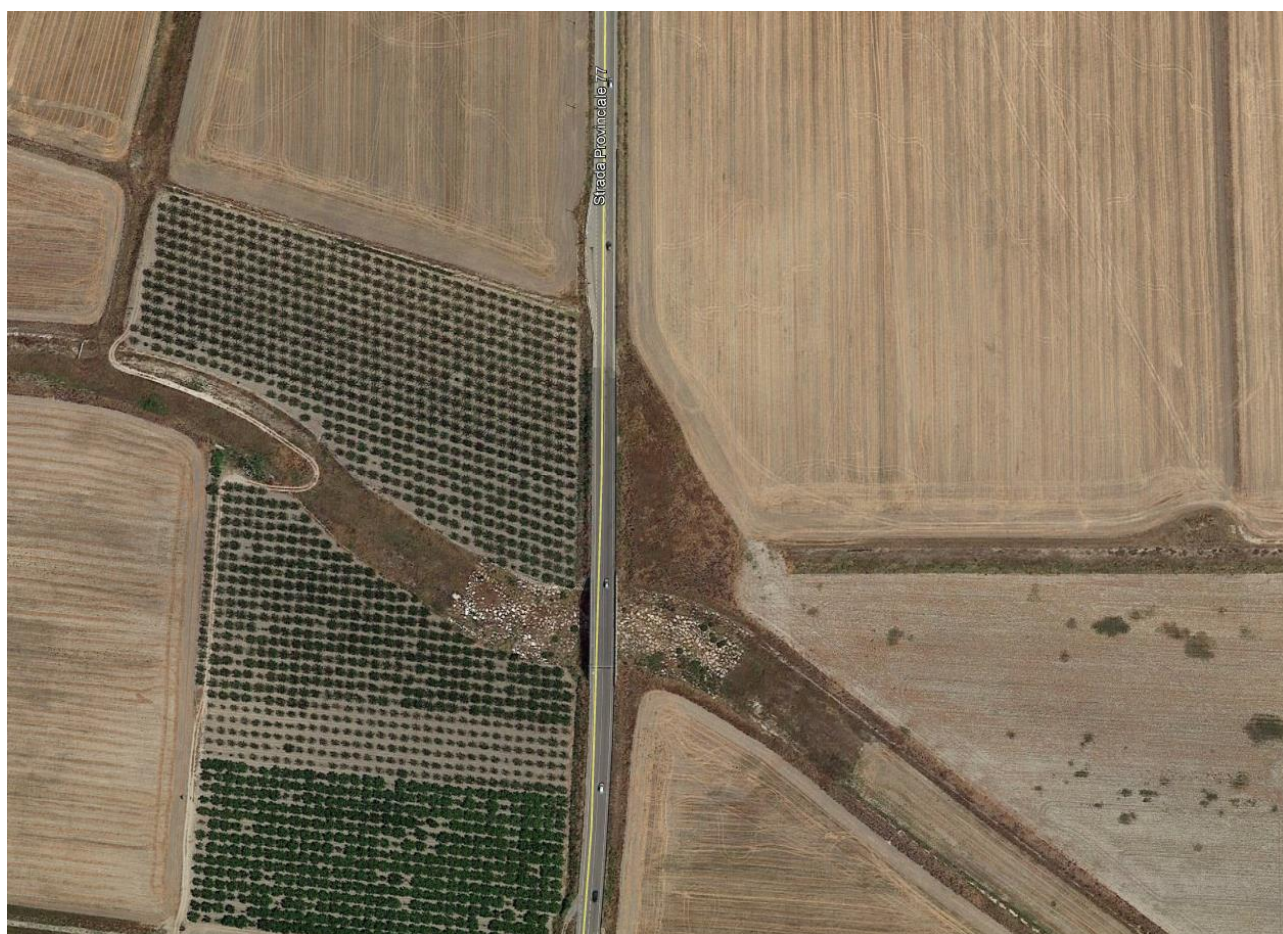
Figura 15 – Vista in ortofoto dell'intersezione tra il Fosso Maran di Castello e la SP77
