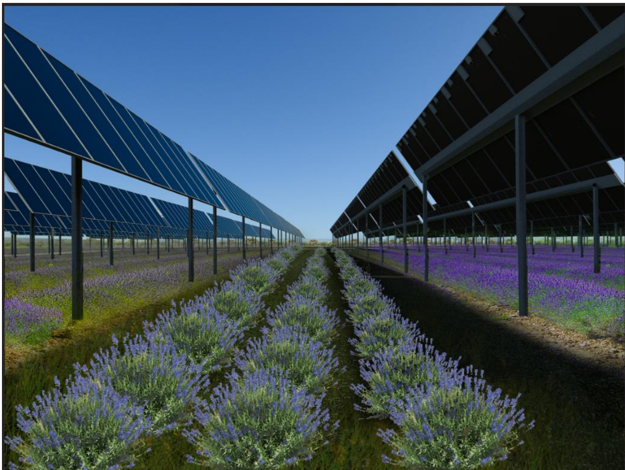
Figura 1 – Fotosimulazione della soluzione adottata con tracker alto monoassiale e distanza tra le file di moduli pari a 5,5 m. Per dettagli sul piano di coltivazione vedi PE17Q60_4.2.6_14_ProgettoAgronomicoPaesaggistico
