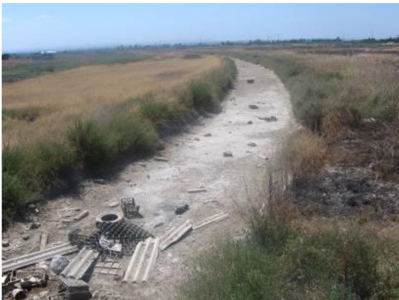
Figura 26 - Abbandono di rifiuti in canali d'acqua
