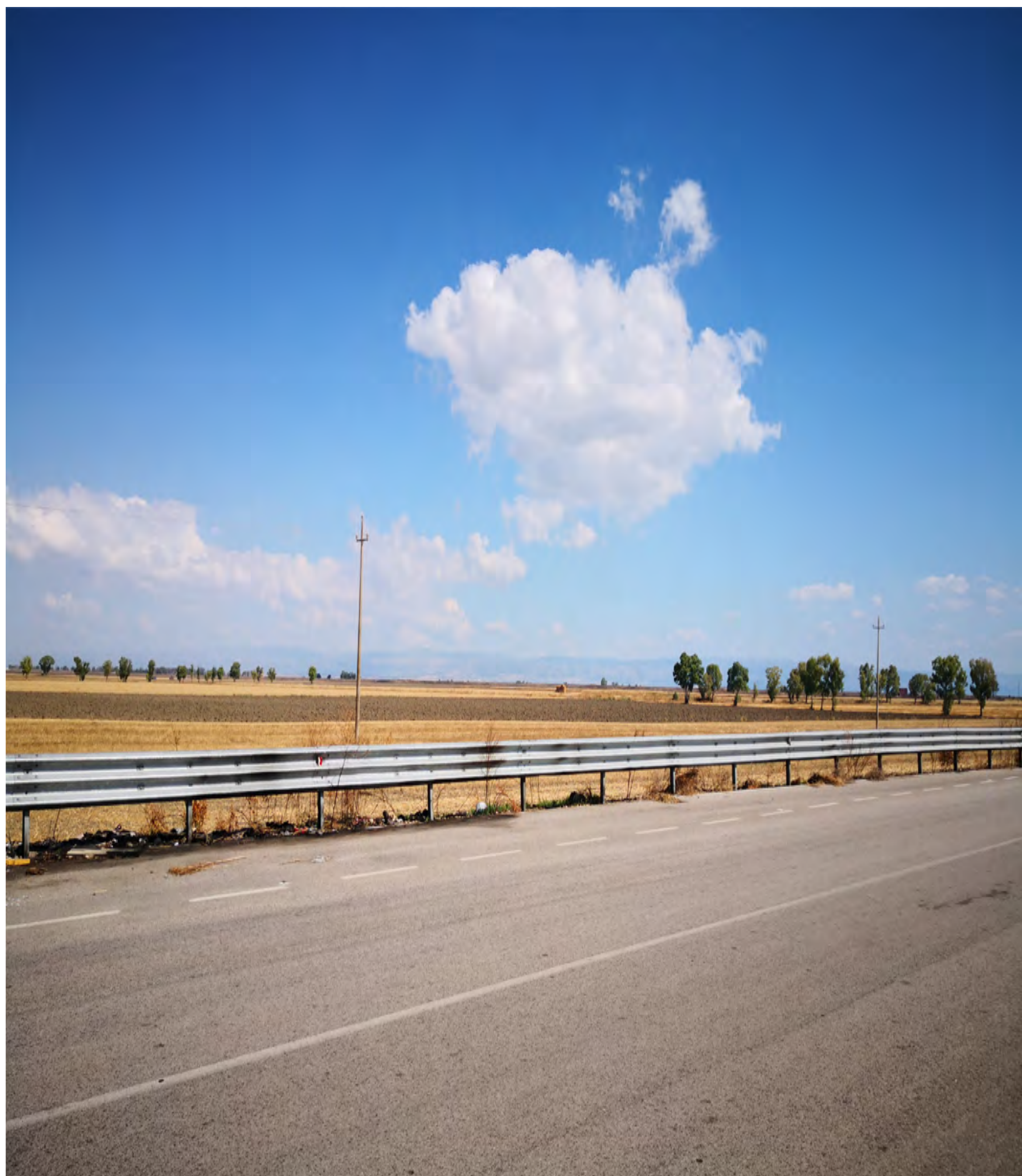
Campo A1 Vista 5 stato di fatto
