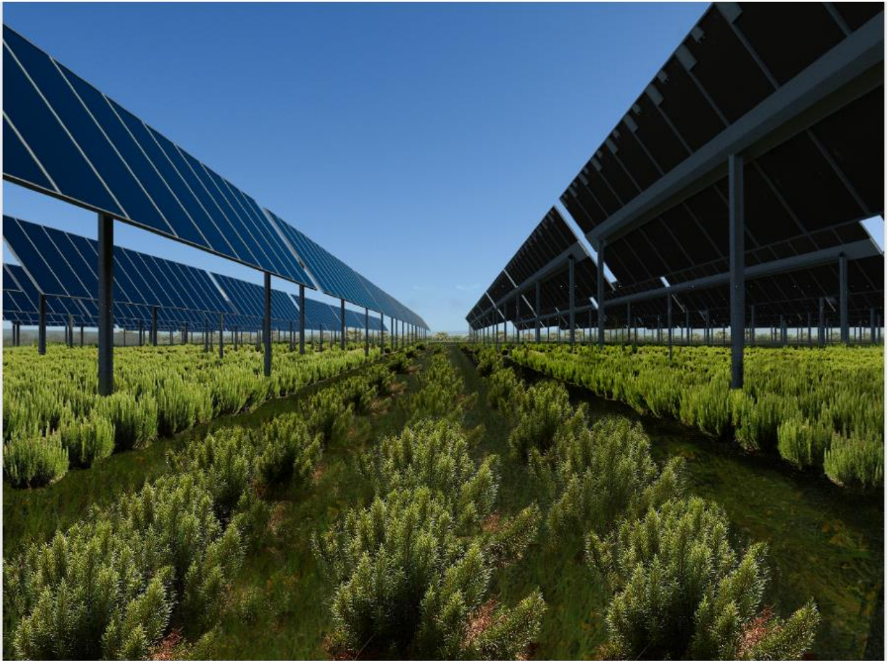
Figura 19 – Fotosimulazione della soluzione adottata con tracker alto monoassiale e distanza tra le file di moduli pari a 5,5 m. In primo piano la coltivazione di rosmarino
