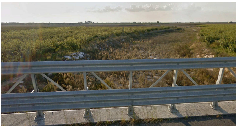
Foto attraversamento della SP 77 con reticolo Sud rivestimento con massi ciclopici)
