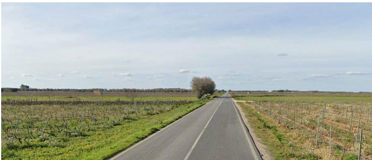
Figura 2-5: Strada San Donaci-Mesagne
