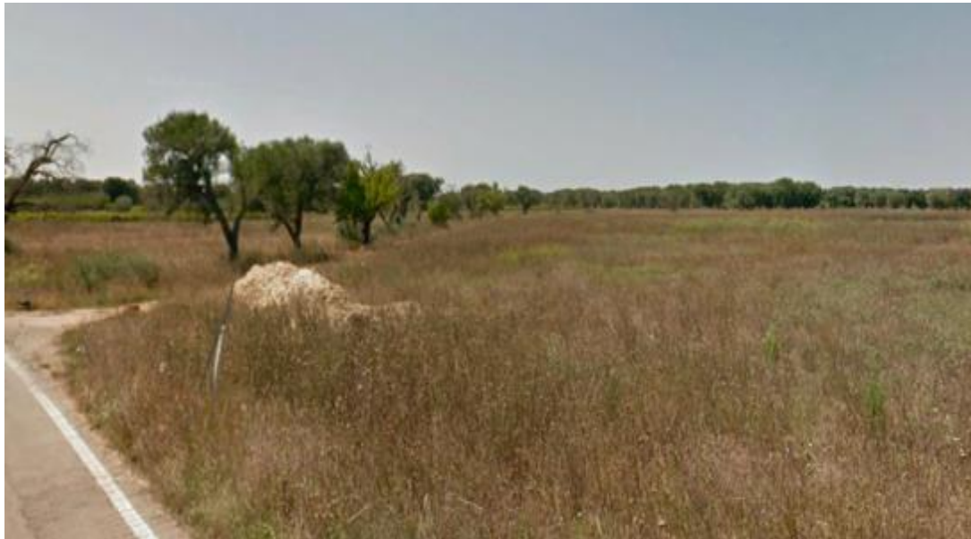
Foto n. 3: area d'imposta della stazione elettrica.
