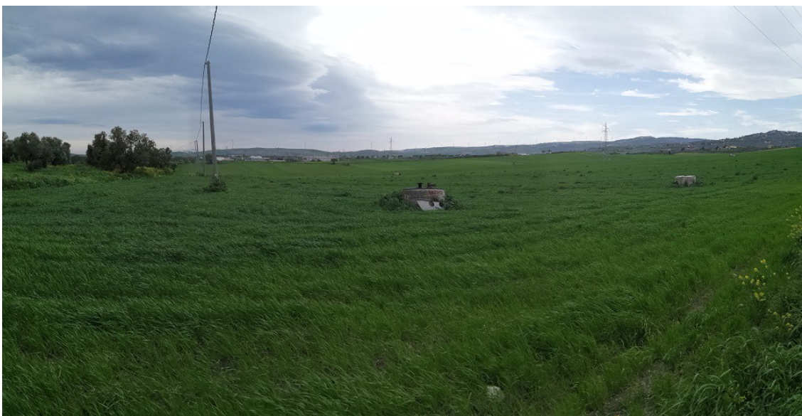
Fig. 13 – Area interessata dal progetto: sono visibili i pozzetti dell'acquedotto e ipali di diverse linee di elettrodotto aereo.
