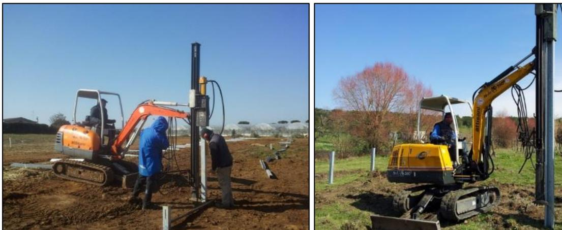
Figura 58 - Tipologia di installazione delle strutture di sostegno dei moduli FTV con macchina battipalo
