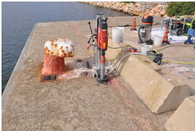
Fotografia 2 – Esecuzione carotaggio
