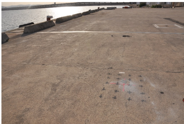
Fotografia 1 – Esecuzione indagine pacometrica
