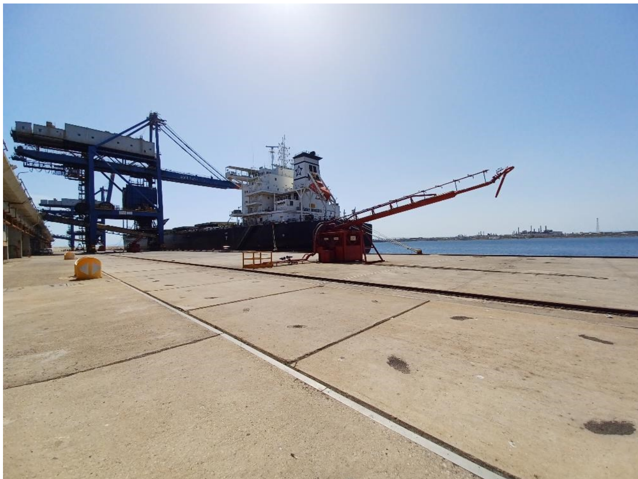
Figura 2.9: Foto No. 09 – Area ad Est dell’Area di Intervento in Banchina, vista da Ovest
