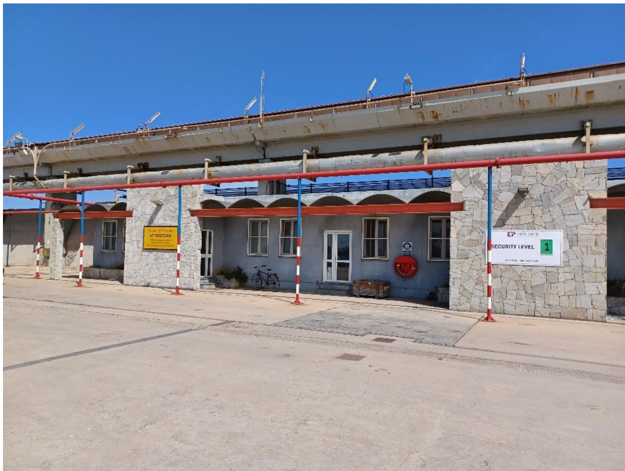
Figura 2.7: Foto No. 07 – Area di Intervento in Banchina, vista da Sud-Ovest. Dettaglio Uffici EP Fiume Santo
