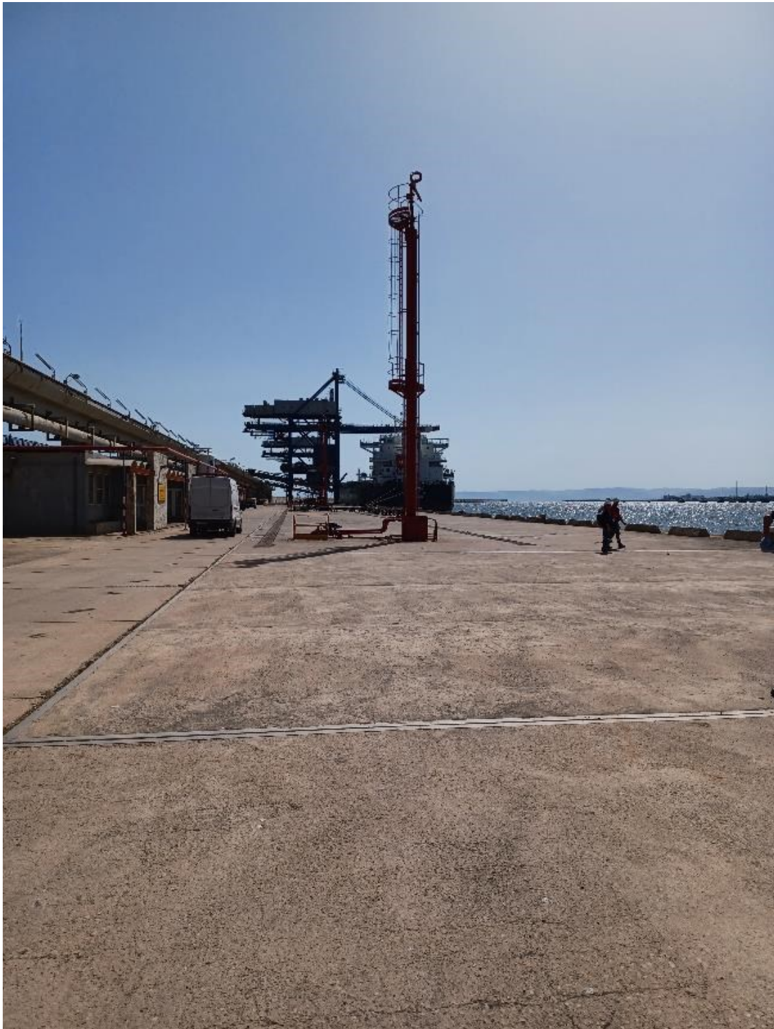
Figura 2.3: Foto No. 03 – Area di Intervento in Banchina, vista da Ovest. Dettaglio Monitore Antincendio
