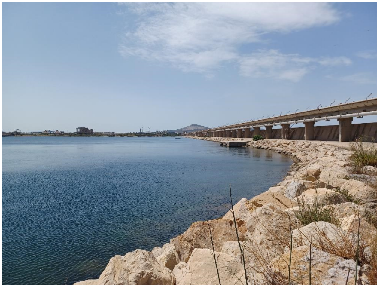
Figura 2.12: Foto No. 12 – Vista da Nord del primo tratto della Diga Foranea
