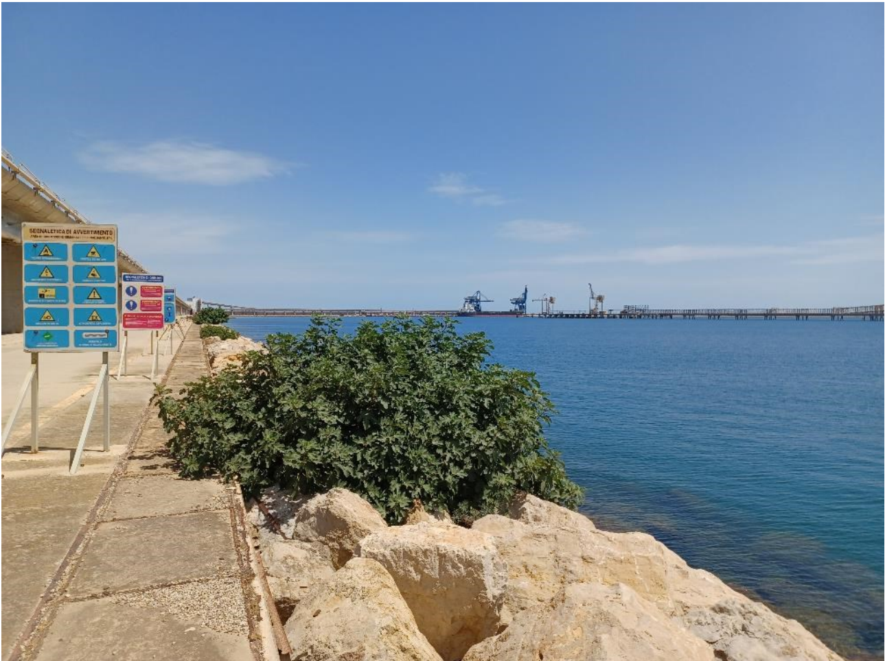
Figura 2.17: Foto No. 17 – Vista da Sud-Ovest della Diga Foranea e dell’Area di Intervento in Banchina
