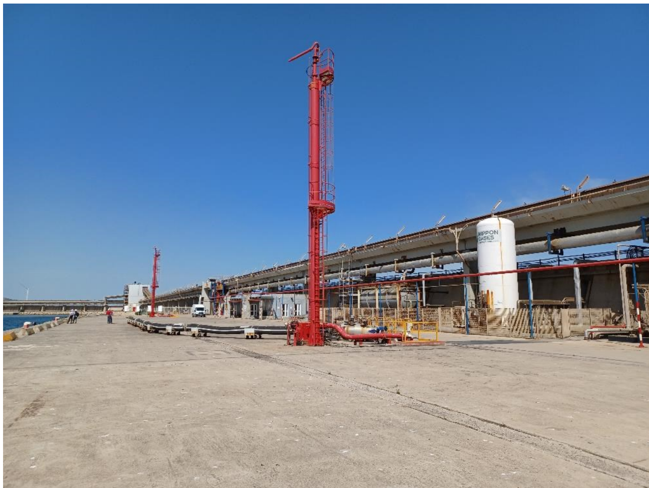
Figura 2.6: Foto No. 06 – Area di Intervento in Banchina, vista da Est
