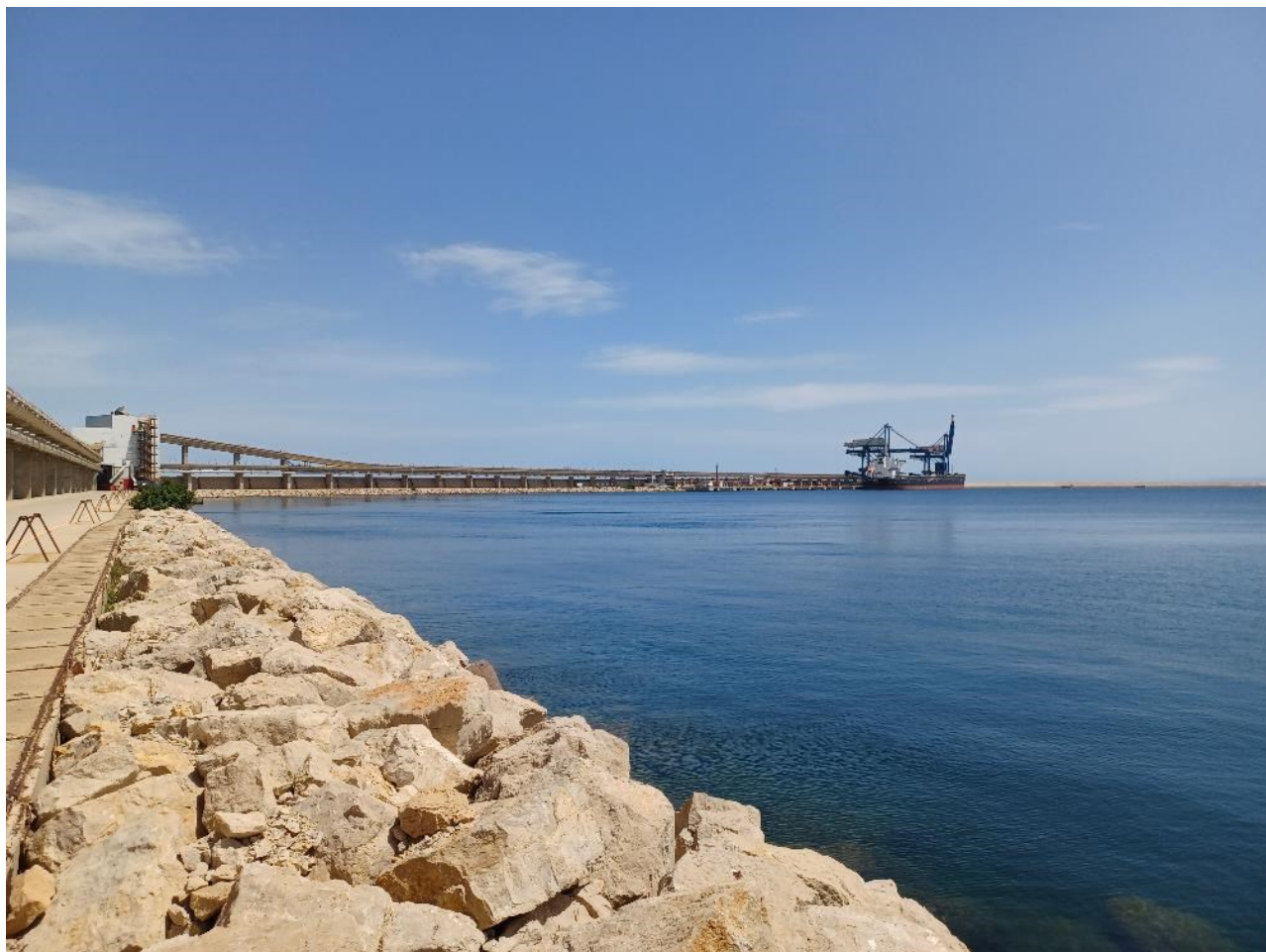
Figura 2.14: Foto No. 14 – Vista da Sud-Ovest dell’Area di Intervento in Banchina
