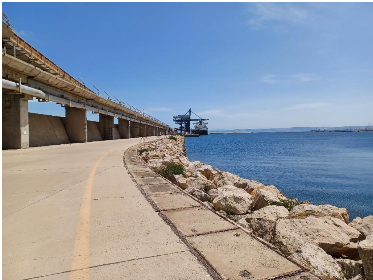
Figura 2.11: Foto No. 11 – Vista da Ovest sull’Area di Intervento in Banchina
