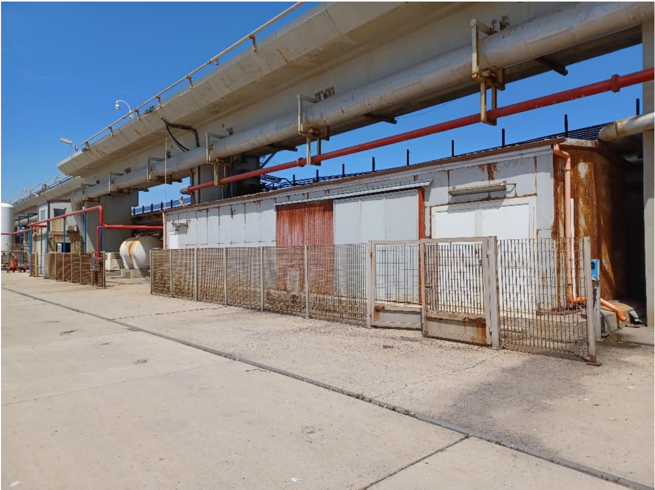
Figura 2.10: Foto No. 10 – Area ad Est dell’Area di Intervento in Banchina, vista da Est
