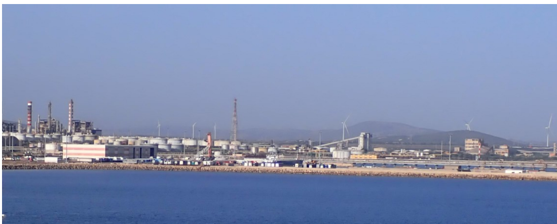
Figura 2.23: Vista dell'Area Industriale da Nord-Est
