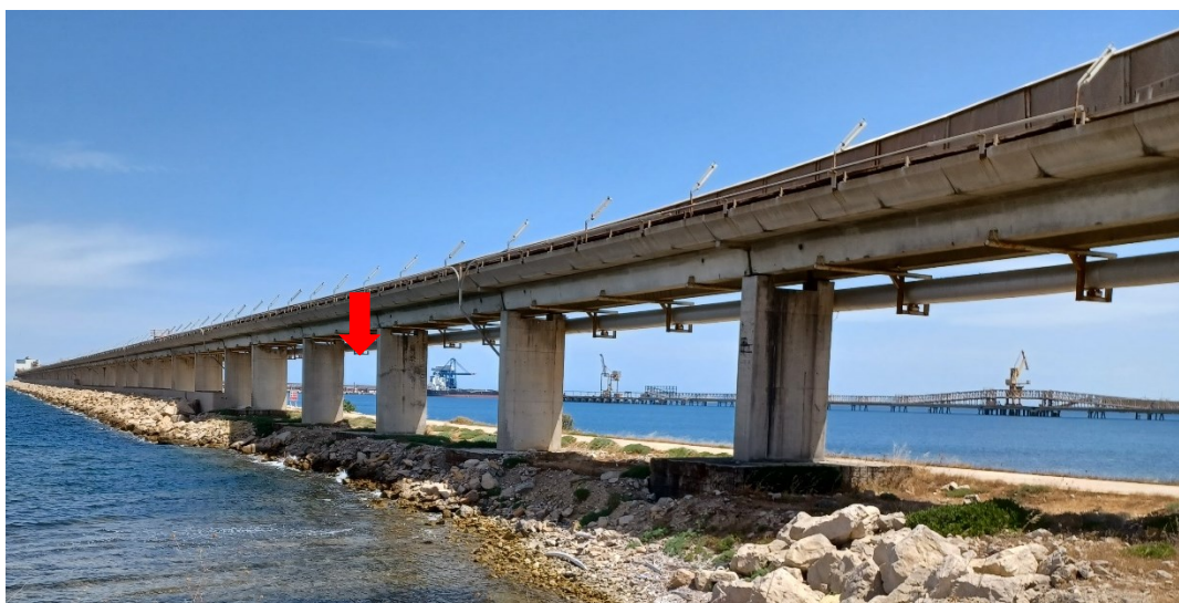
Figura 2.25: Vista da Sud, Struttura Trasporto Carbone
