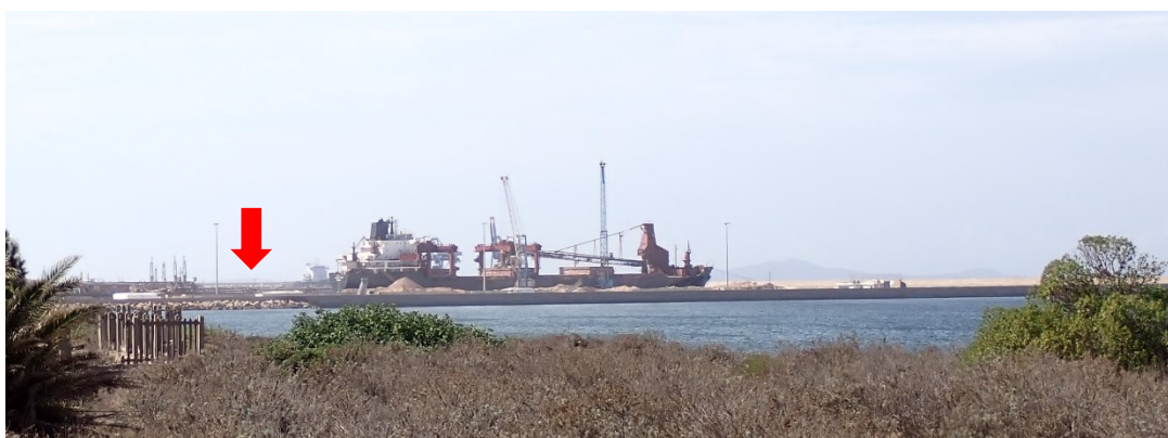
Figura 2.26: Vista dalla E25 tra Porto Torres e l'Area Industriale
