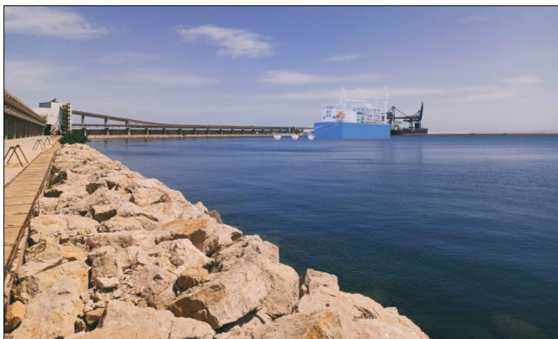
STATO FUTURO - DIGA FORANEA (AREA INDUSTRIALE NON FRUIBILE)
