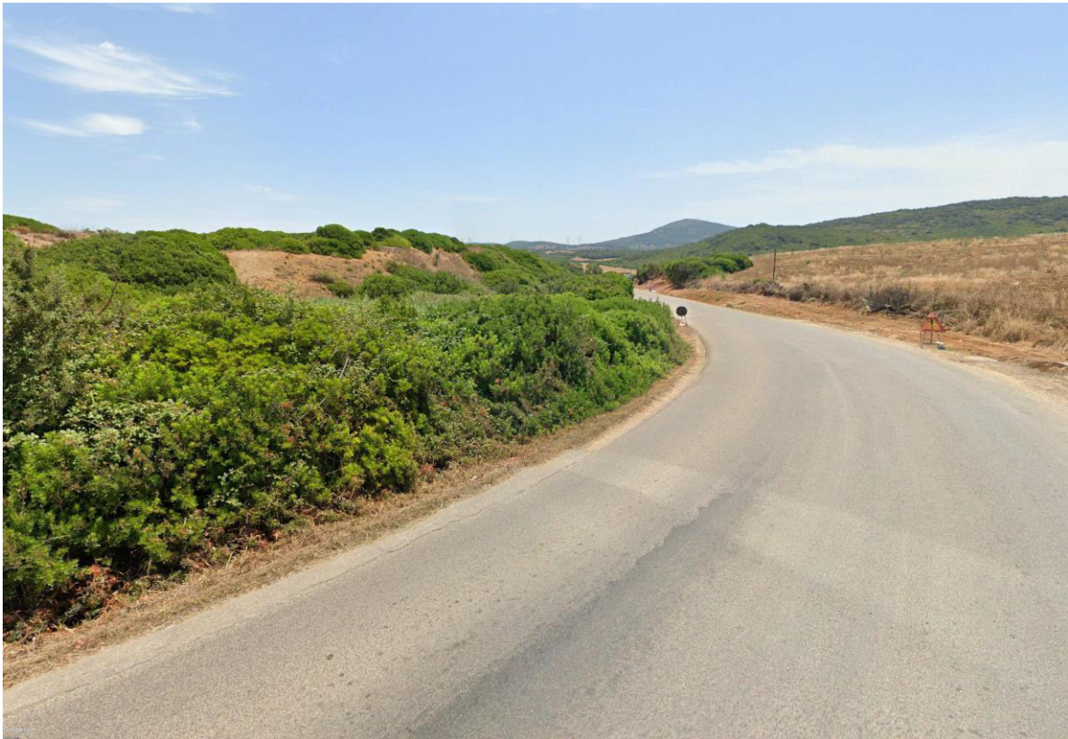
Figura 23: Vista dal punto 2_ strada SP 24_ verso l'area di impianto 1
