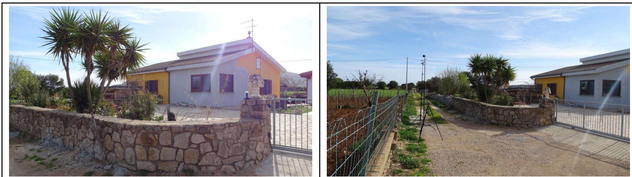
Figura 3.7-3 - Documentazione fotografica postazione di monitoraggio
