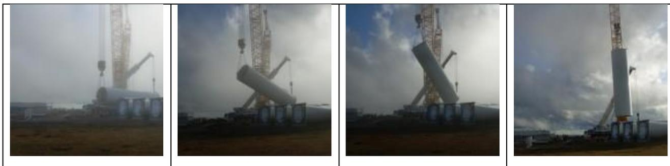
Figura 5.26 – Schema delle fasi di sollevamento dei componenti dell'aerogeneratore (Fonte sito web <http://www.windfarmbop.com/> )
