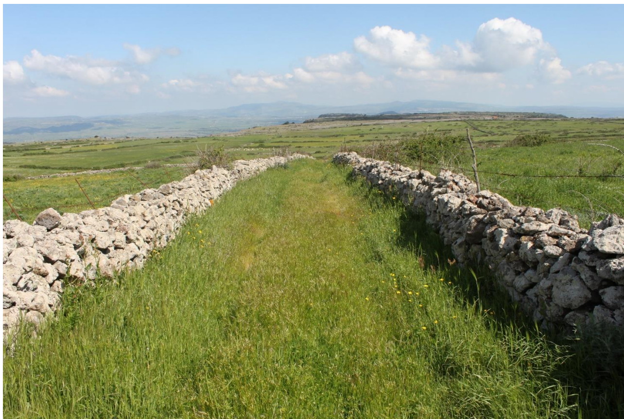
Figura 5.17 – Esistente strada interpoderale da adeguare per il collegamento della postazione eolica T7 (vista
