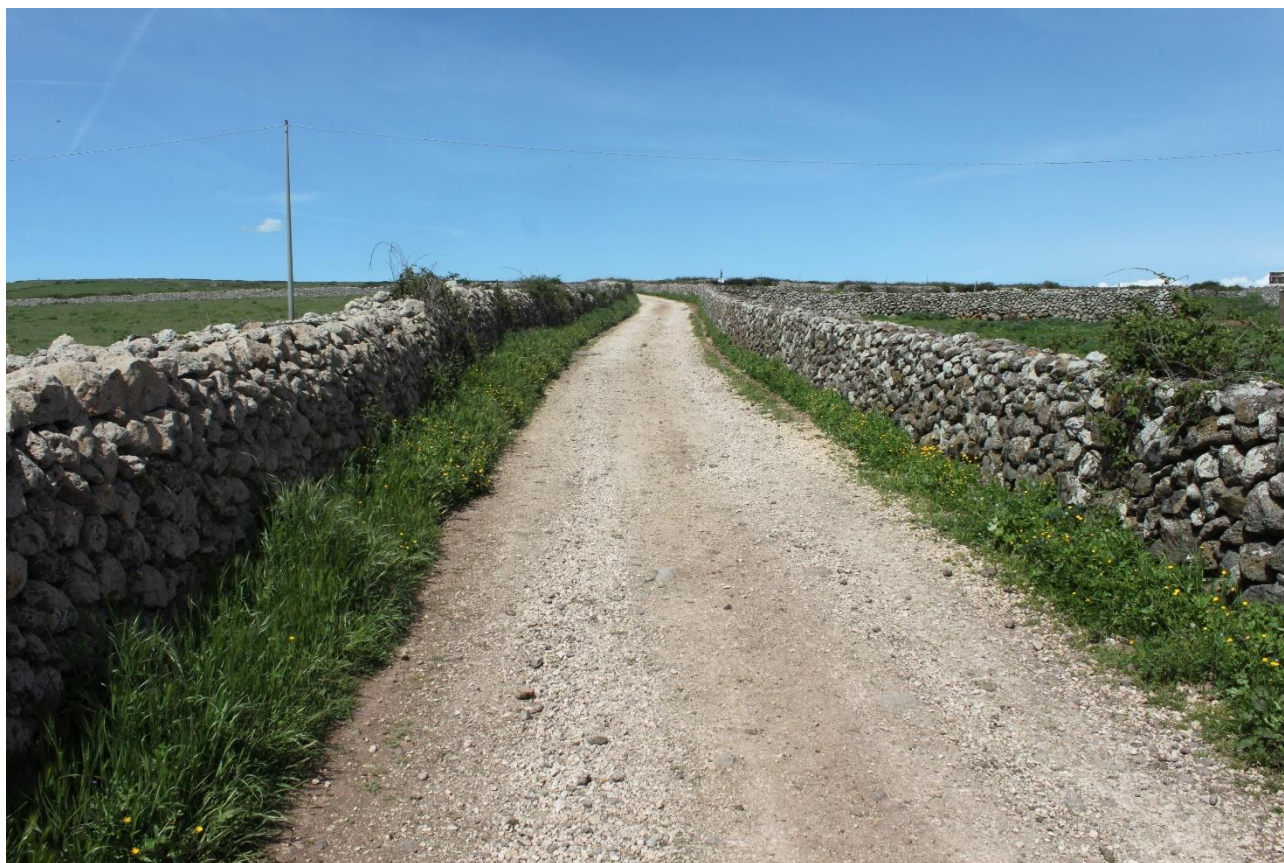
Figura 5.4 – Esistente viabilità da adeguare in prossimità della postazione T4 facente parte della viabilità di progetto (vista verso nord)
