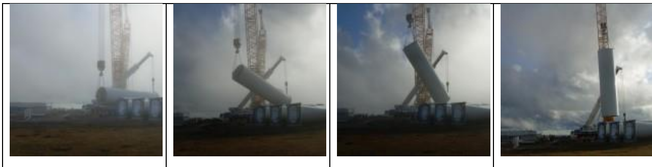
Figura 5.28 – Schema delle fasi di sollevamento dei componenti dell'aerogeneratore (Fonte sito web http://www.windfarmbop.com/ )
