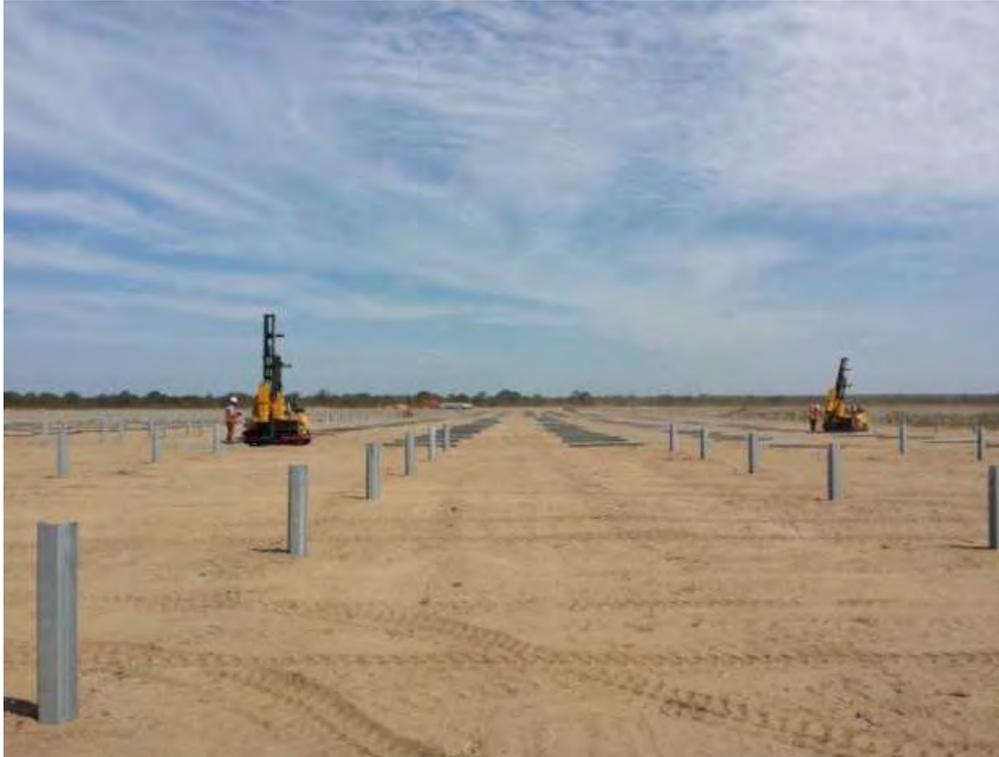
*Figura 19 - Esempio di disposizione dei pali di fondazione delle strutture*
