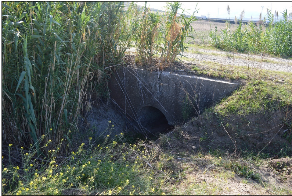
Figura 19: INT.01 - Struttura di attraversamento del corso d'acqua
