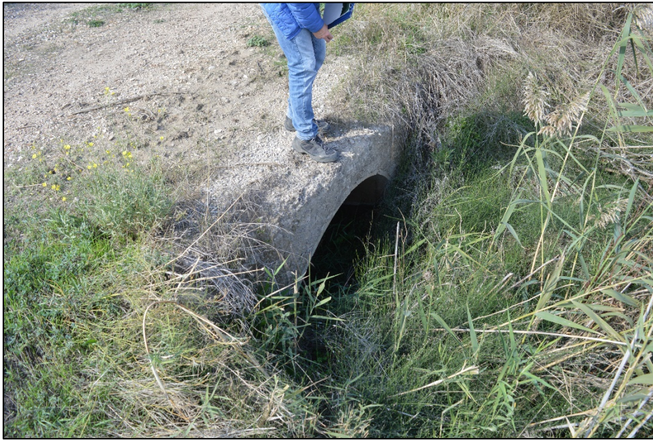
Figura 25: INT.04 – Attraversamento in cemento dell'asta del reticolo idrografico
