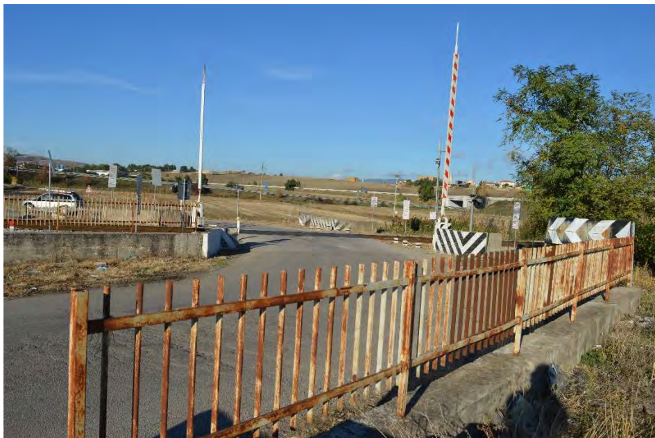
Figura 7: punto di scatto 4, intersezione con la linea ferroviaria – passaggio a livello
