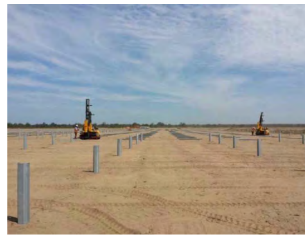
MONTAGGIO CON INFISSIONE SENZA FONDAZIONE
