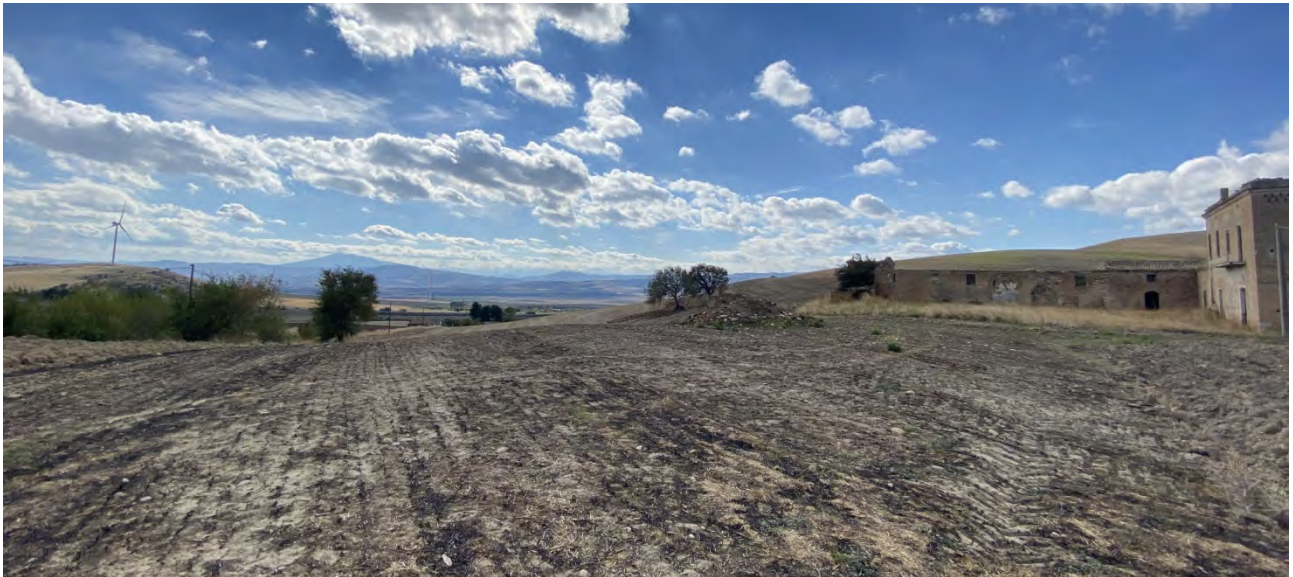
F2 ANTE / POST OPERAM- VISIBILITA NULLA - Lo scatto è effettuato in prossimità della Masseria S. Mercurio, di cui a destra della foto sono visibili i ruderi. L'edificio versa in stato di abbandono, come gran parte del patrimonio rurale del Tavoliere. Da questo osservatorio, che si trova in cima alla collina, non è visibile. l'impianto in progetto, che sarà posizionato al di sotto del versante.
