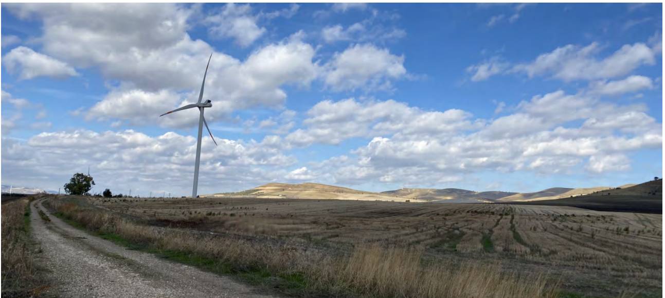
F3 POST OPERAM - Dalla foto, scattata in una località a sud dell'area destinata al progetto, è parzialmente visibile al centro della foto una piccola parte dell'impianto agro voltaico, mentre sulla sinistra si scorge appena una porzione appartenente al lotto A. Nel complesso l'impatto visivo da questo punto non può dirsi particolarmente critico.
