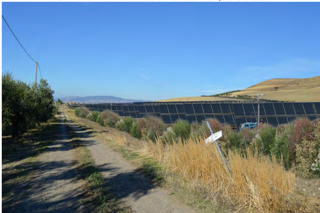
FS. 1 POST OPERAM- La foto mostra l'impianto agro-voltaico in esercizio, con le fasce di mitigazione suggerite dalla vegetazione spontanea di margine
