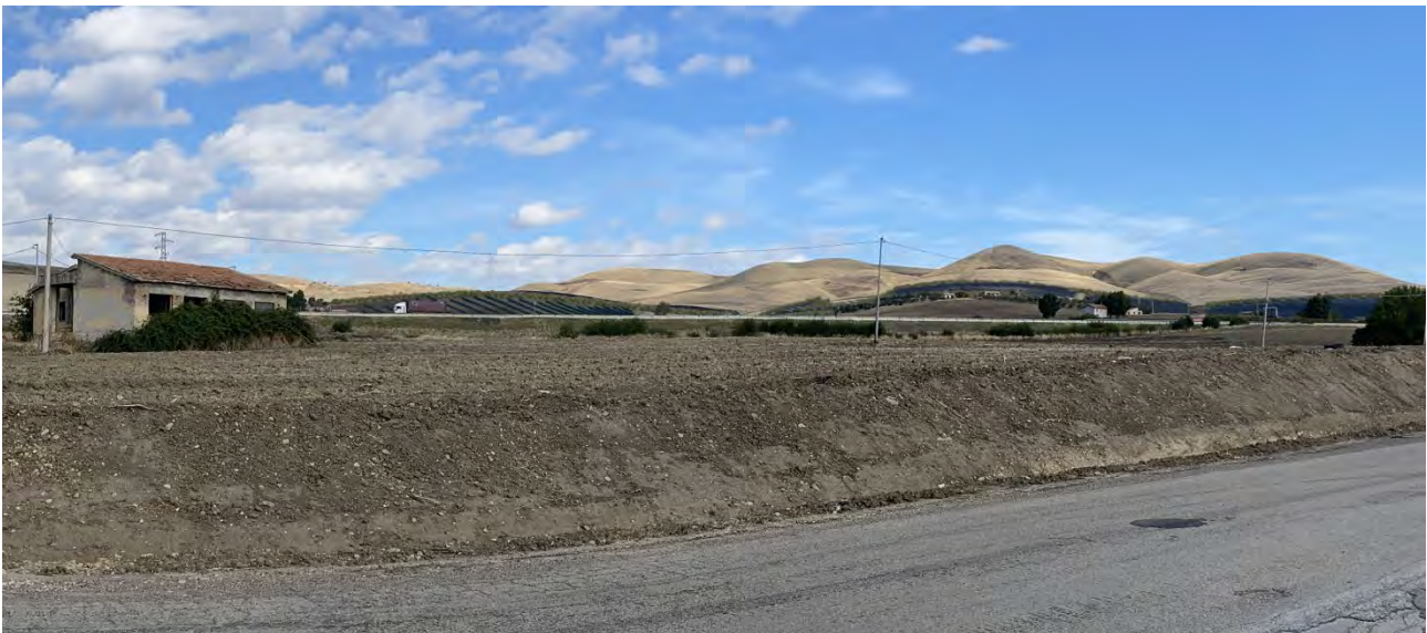
F1 POST OPERAM- Dal punto di scatto l'impianto è visibile oltre la linea dell'autostrada. Il paesaggio presenta una sovrapposizione di segni vecchi e nuovi e in tale contesto la cesura dell'autostrada si impone come segno dominante. L'impianto agrovoltaiico in progetto rimarca le forme lievemente ondulate delle pendici collinari, adagiandosi su di esse, mentre si allinea ai filari di olivi preesistenti, come a riprenderne lo schema compositivo. Nel complesso si può affermare che, pur con l'introduzione di un nuovo segno, l'impatto visivo dell'impianto di inserisce in maniera armonica nelle linee del paesaggio.
