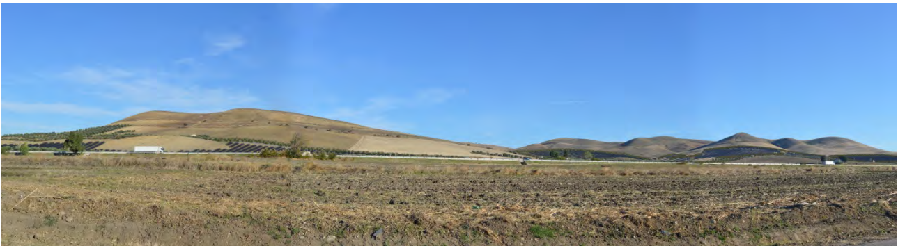
F6 POST OPERAM - La foto è stata scattata un punto di massima visibilità situato lungo il Tratturo, l'impianto si riconosce nella sua totalità, alle pendici dei colli. Le linee sembrano ancora una volta rimarcare i segni degli elementi del suolo agricolo e dei filari di olivi già presenti in sito, e nel complesso l'insieme si presenta in armonia con il contesto.
