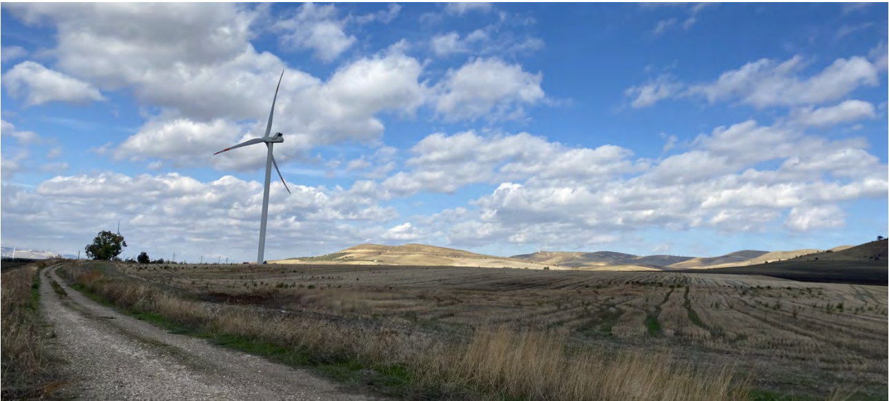
F3 ANTE OPERAM - Scatto effettuato nei pressi della Masseria Piano Morto
