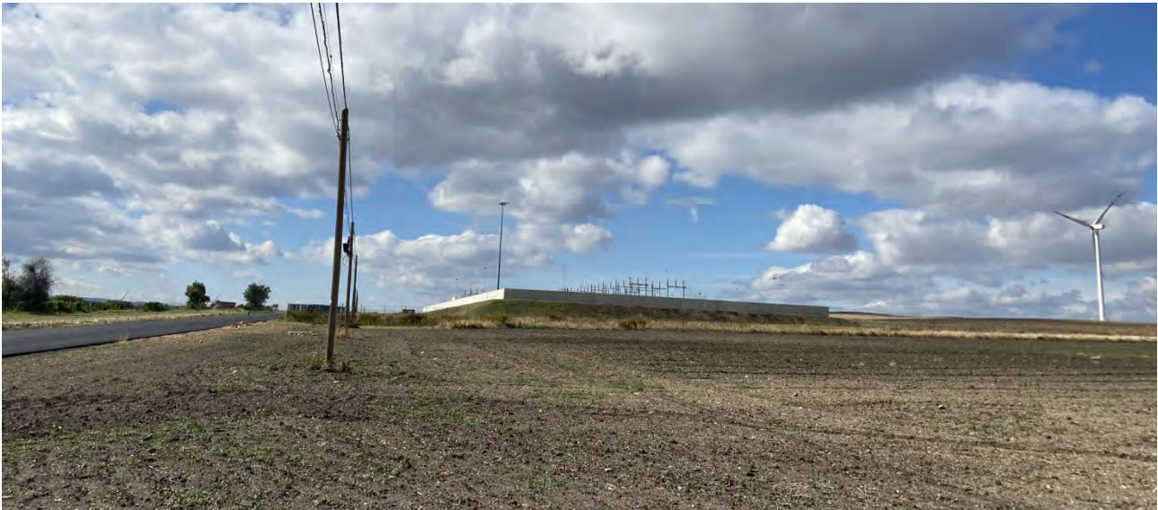
F8 ANTE OPERAM - Lo scatto , effettuato dal trattorello Foggia - Ascoli - Lavello , mostra l'area destinata alla sottostazione.
