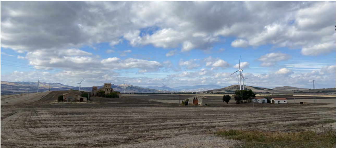
F4 ANTE / POST OPERAM- VISIBILITA NULLA - Dalla foto scattata da Masseria della Mendola, l'impianto non è visibile in quanto celato dal crinale di Serra del Riposo
