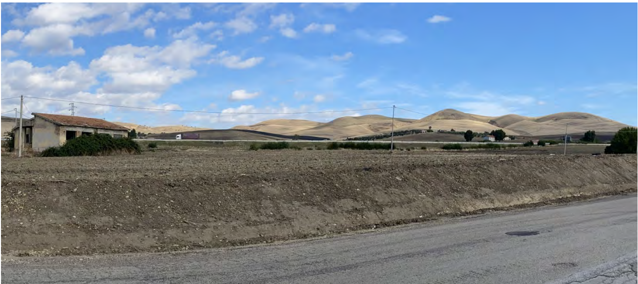
F1 ANTE OPERAM- Scatto effettuato in prossimità della Masseria del Riposo, guardando verso il lotto B dell'area di progetto e verso il profilo collinare del monte la Fica. La foto è scattata dalla SP 95, che in questo tratto si sovrappone al tracciato del Tratturo Pescasseroli Candela. In primo piano è visibile la cesura dell' autostrada A 16.
