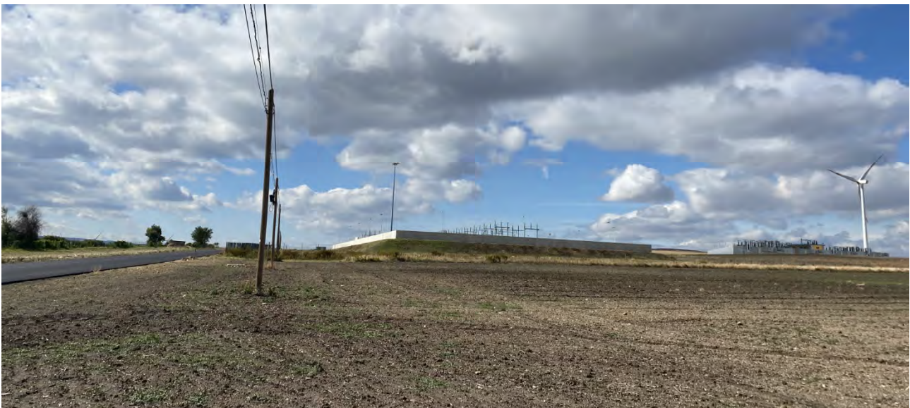
F8 POST OPERAM - Alla destra della foto è visibile il fotomontaggio con la sottostazione utente. L' elemento che si introdurrà nel contesto di riferimento sarà della stessa tipologia ma di dimensione inferiore rispetto all'esistente e questo non sarà sufficiente a generare un'alterazione dei caratteri del paesaggio, che ha già perso i connotati originari.
