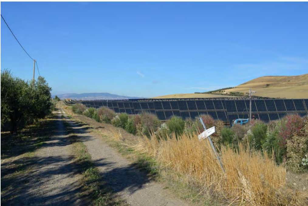
FS. 1 POST OPERAM- La foto mostra l'impianto agro-voltaico in esercizio, con le fasce di mitigazione suggerite dalla vegetazione spontanea di margine
