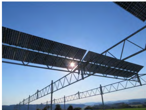
Figura 1 - I primi moduli fotovoltaici visti dal basso (Fraunhofer ISE)
