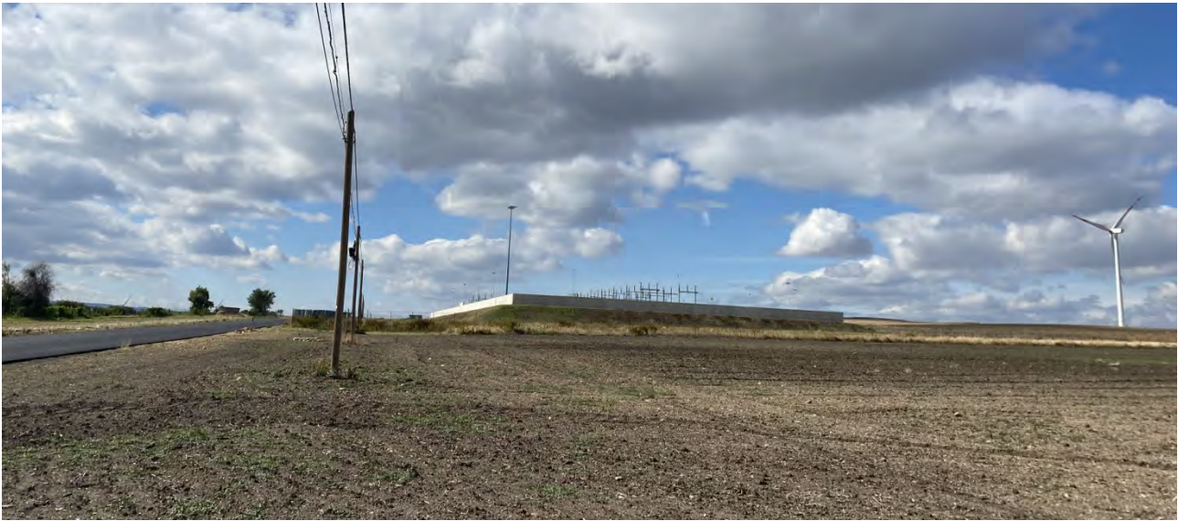
F8 ANTE OPERAM - Lo scatto , effettuato dal tratturello Foggia - Ascoli - Lavello, mostra l'area destinata alla sottostazione.
