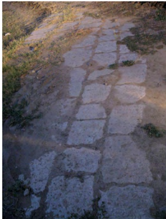
Figura 15- Basolato di pavimentazione della via Herdonitana
