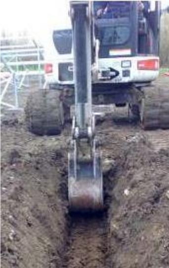
La prima fase è quella di compiere mediante pala meccanica le operazioni di scavo dopo gli opportuni tracciamenti. Successivamente vengono posizionati i cavidotti attraverso i quali saranno poi stesi i diversi cavi necessari. I cavidotti saranno poi ricoperti con terreno e nastro di indicazione come previsto in fase di progetto. Il reinterro è previsto con il materiale proveniente dagli scavi; le eccedenze saranno smaltite in discarica.
