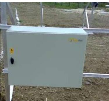
Le operazioni da eseguire sono in questo caso la posa in opera delle staffe ed il fissaggio ad esse del quadro di campo in continua; vengono poi completate alcune iniziali operazioni di cablaggio.
