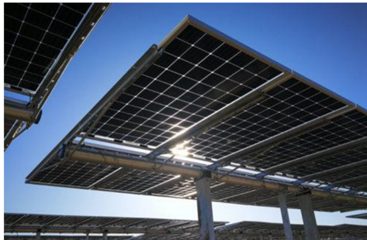
Figura 3.3: Particolare strutture di sostegno moduli
