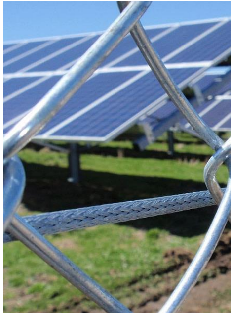
Figura 4.10 – Cavo in fibra ottica montato su rete metallica.
