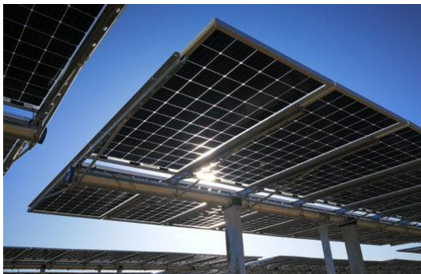
Figura 3.2: Esempio di struttura a tracker monoassiale
