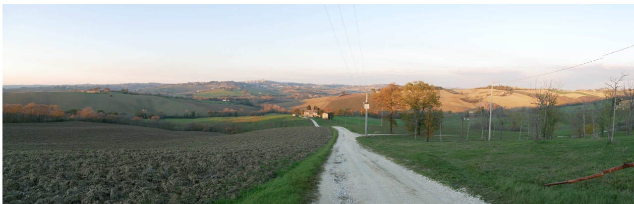
Foto 1 – Panoramica dell'area oggetto di intervento
