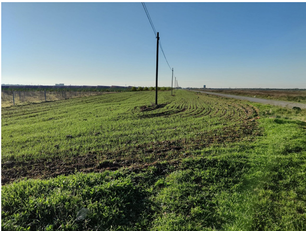
Figura 7.4 Visuale n. 3 dell'area di progetto nei pressi della S.P. 109: stato ante-operam e post-operam
