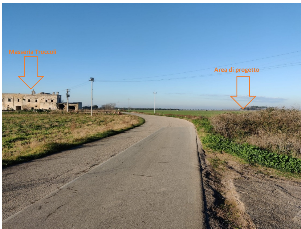
Figura 2.25 Vista dell'area di intervento lungo la S.P. 107 in corrispondenza della Masseria Troccoli
