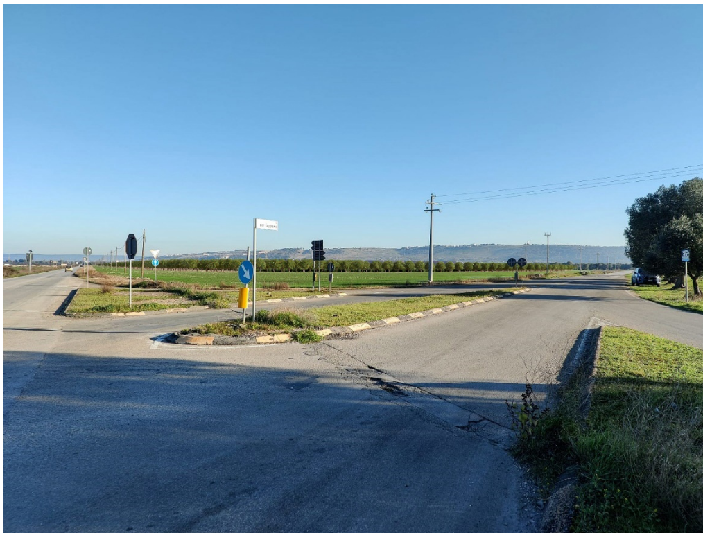
Figura 3.2 Visuale n. 2 dell'area di progetto in corrispondenza dell'incrocio della S.P. 107 e S.P. 109: stato ante-operam e post-operam
