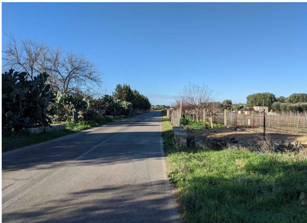
Figura 2.32 Vista 2 lungo il tracciato dell'elettrodotto in corrispondenza dell'incrocio con il Canale Maestro
