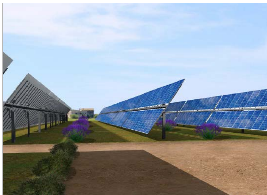
Figura 4.11 Vista interna al campo fotovoltaico in direzione della Masseria Troccoli
