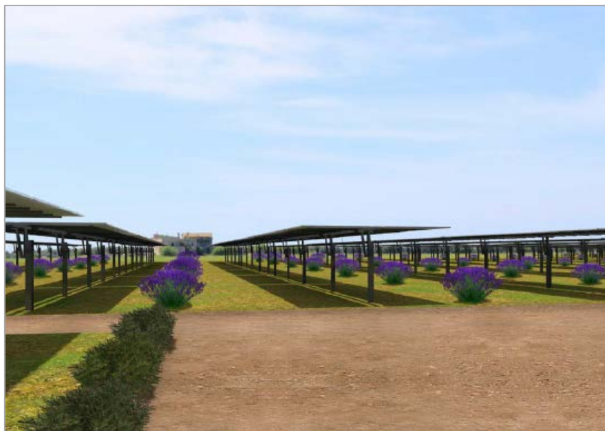
Figura 4.12 Vista interna al campo fotovoltaico in direzione della Masseria Troccoli
