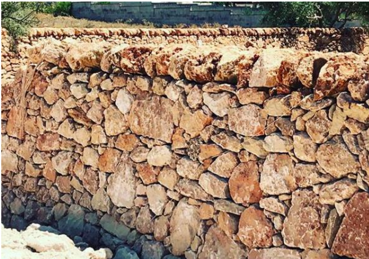
Figura 18 esempio di muratura a secco con "coperta" superiore.
