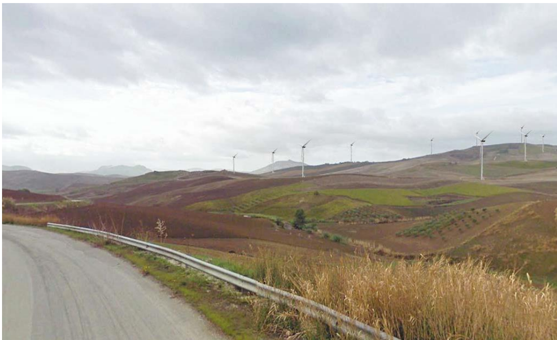
Vista 2 - Stato post-operam (SP106)
