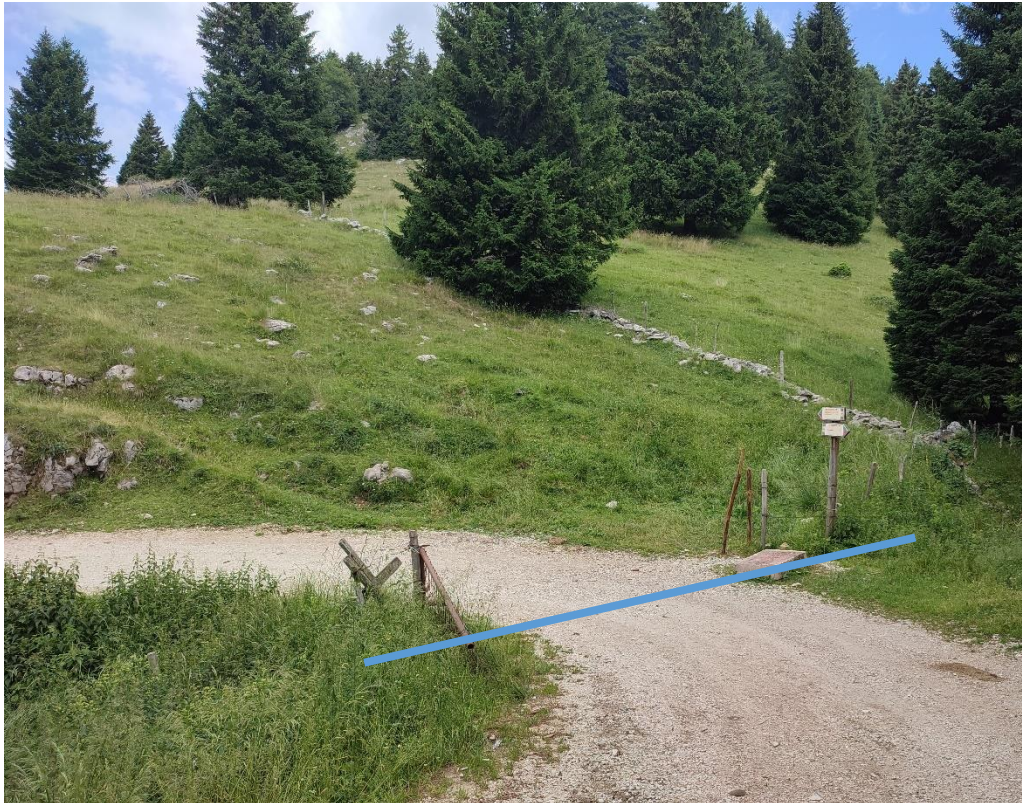
Figura 3: Vista attraversamento stradale Vaio Folignano. Si riporta in azzurro il tracciato del tombamento.
