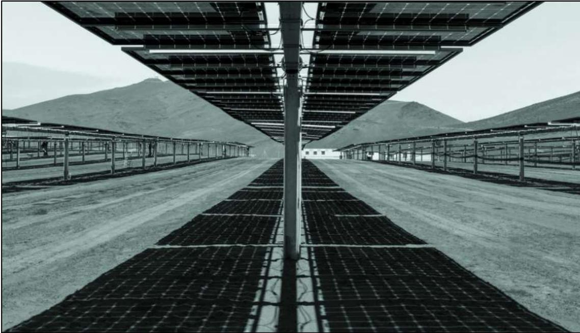
*Figura 36 - Esempi di tracker per impianti fotovoltaici*
