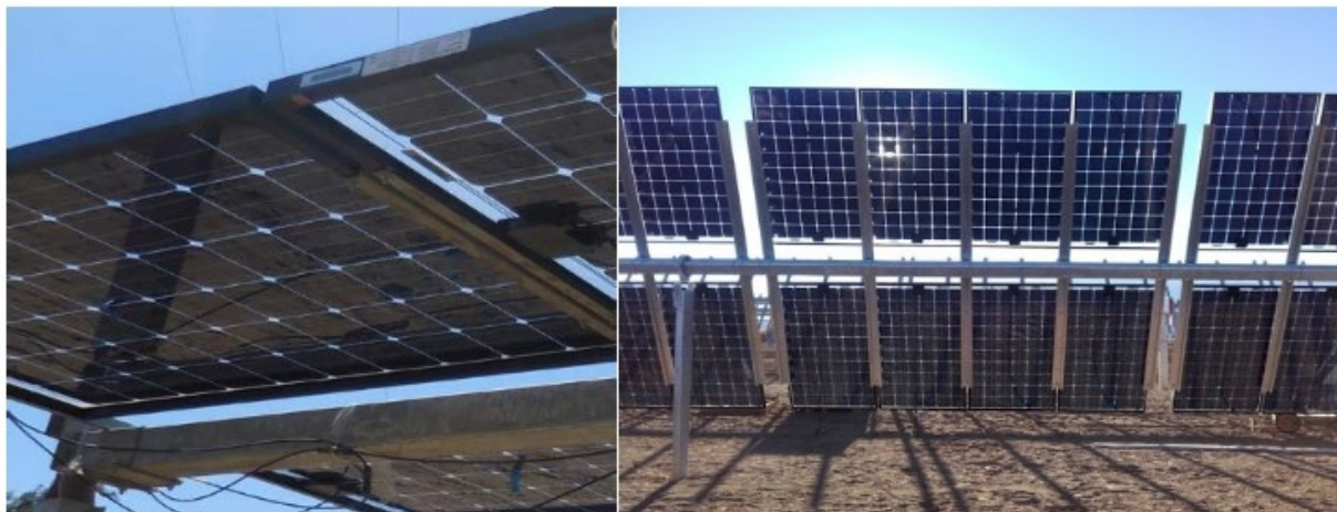
Rappresentazione indicativa struttura sostegno e moduli fotovoltaici
