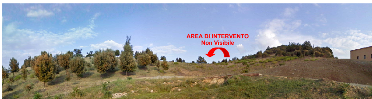
Figura 45: Vista POST OPERAM dal PS16, Abbazia di Santa Maria d'Orsoleo a Sant'Arcangelo
