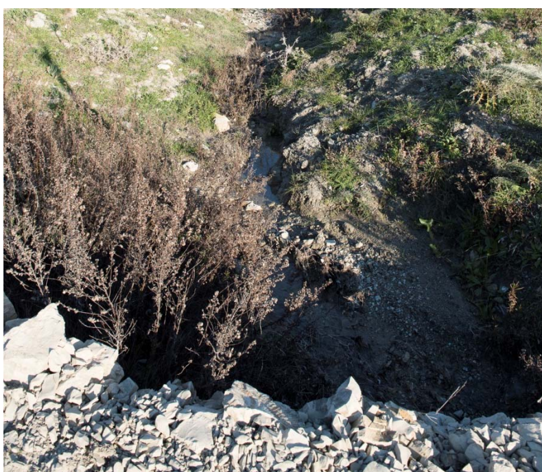
Figura 27: Fosso da attraversare con cavo interrato al di sotto della nuova tombinatura
