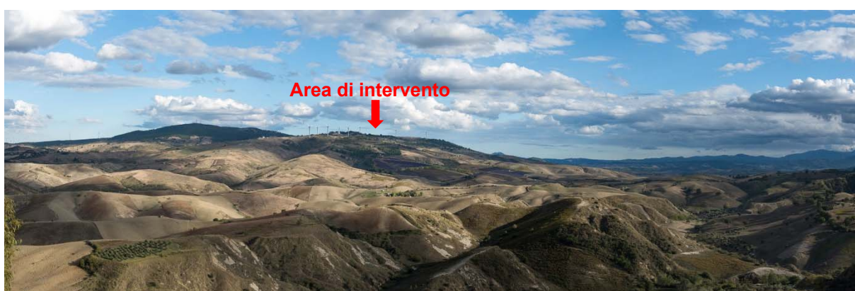
Figura 38: FOTOISERIMENTO dell'impianto e degli impianti FER autorizzati e in corso di autorizzazione.
