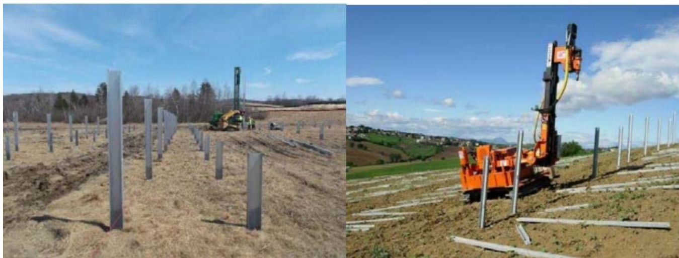
Figura 8: Infissione profili di palificazione
