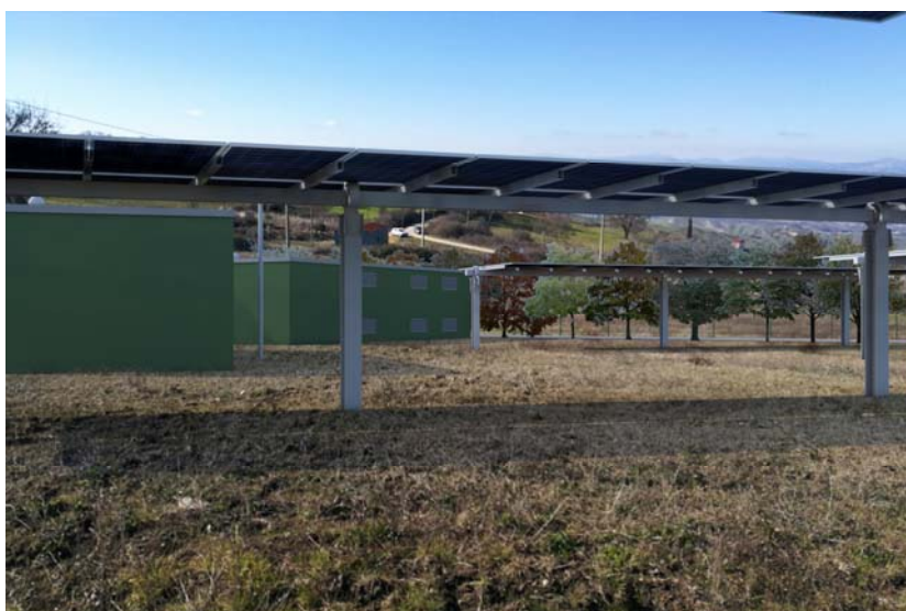
Figura 74: Vista V03 interna in prossimità dell'accesso al sito – Post Operam con opere di mitigazione
