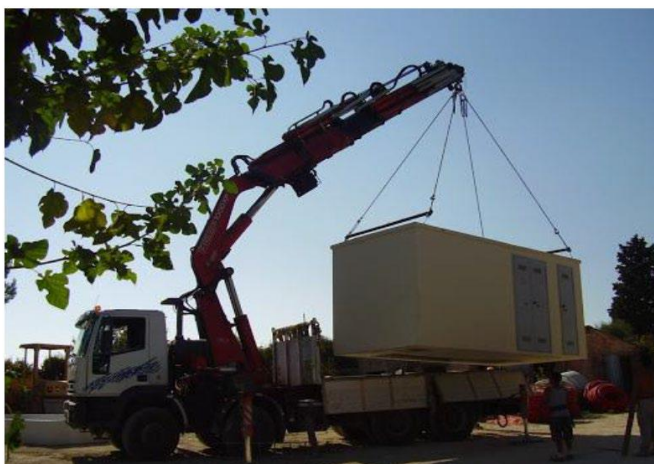
Figura 11: Fornitura e posa in opera delle cabine di raccolta e delle Power Station
