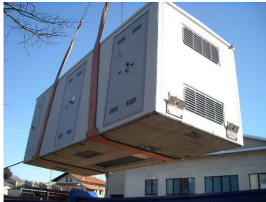
Figura 2: Fornitura e posa in opera delle cabine di raccolta e delle Power Station
