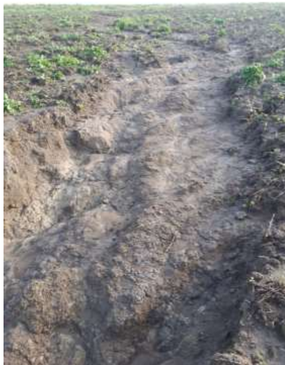
Figura 5 – erosione dovuta alle acque di ruscellamento superficiale
