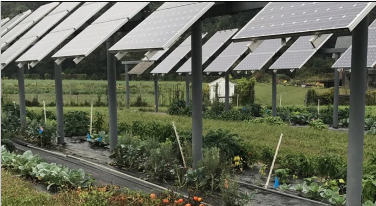
Figura 6.2. Agrovoltaico a moduli fissi con struttura a falde in Cina, in un campo coltivato a bacche di Goji
