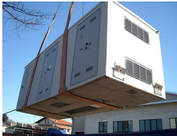
Figura 23: Fornitura e posa in opera delle cabine di raccolta e delle Power Station
