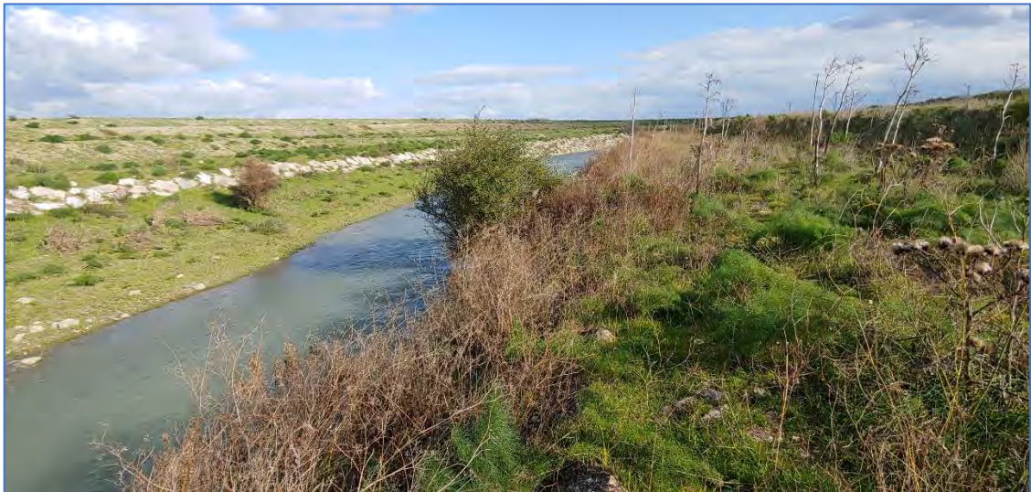
(Fig.23 Ponte Torrente Cervaro, Vista Monte n.2)
