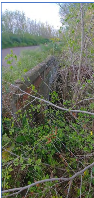
(Fig.32 Ponte "Affluente Canale Properzio")
