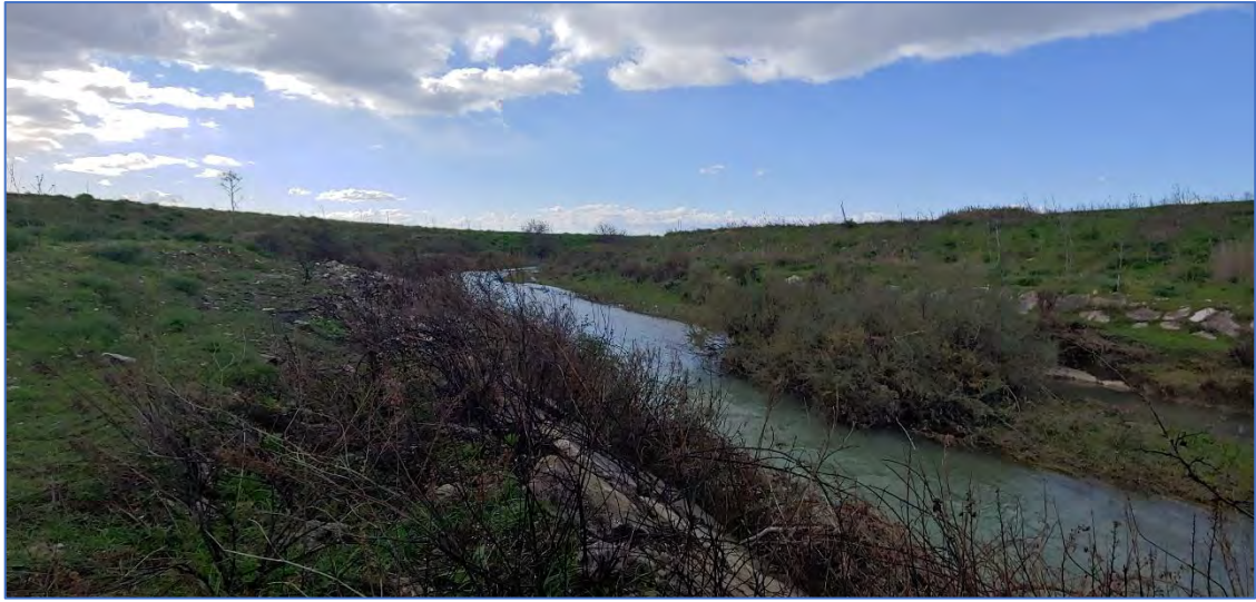
(Fig.22 Ponte Torrente Cervaro, Vista Monte n.1)
