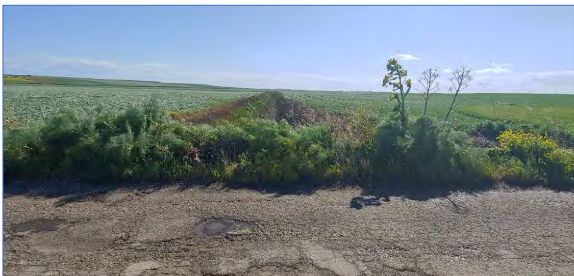
(Fig.30 Ponte "Canale Properzio" Vista Valle)
