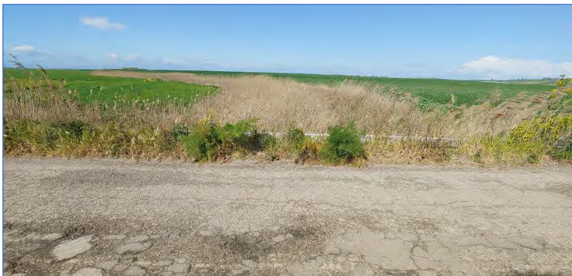
(Fig.29 Ponte "Canale Properzio" Vista Monte)
