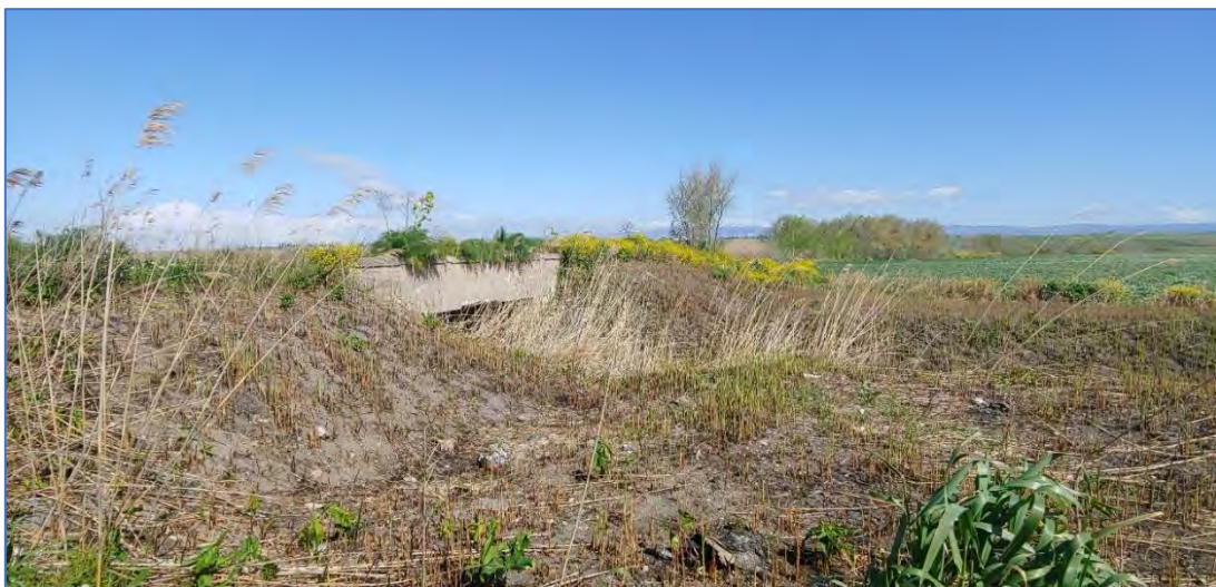
(Fig.28 Ponte "Canale Properzio")
