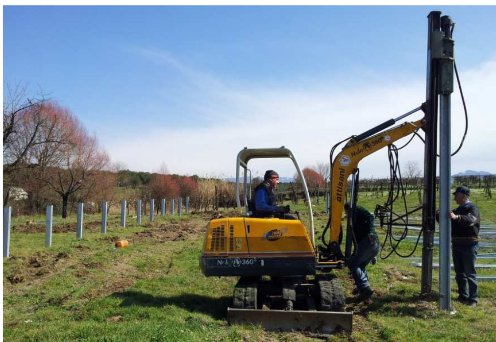
Figura 6-4: Infissione per battitura
