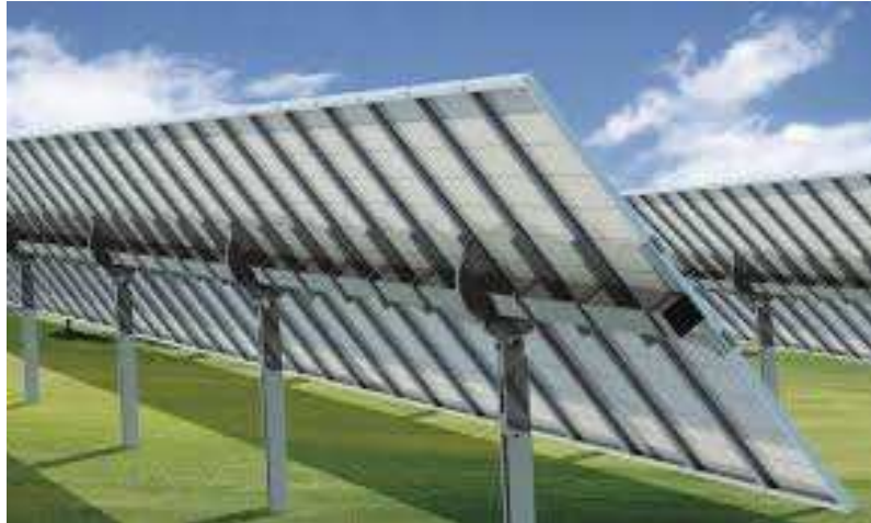
Figura 4 Esempio di tracker fotovoltaico con vela tipo 2V
