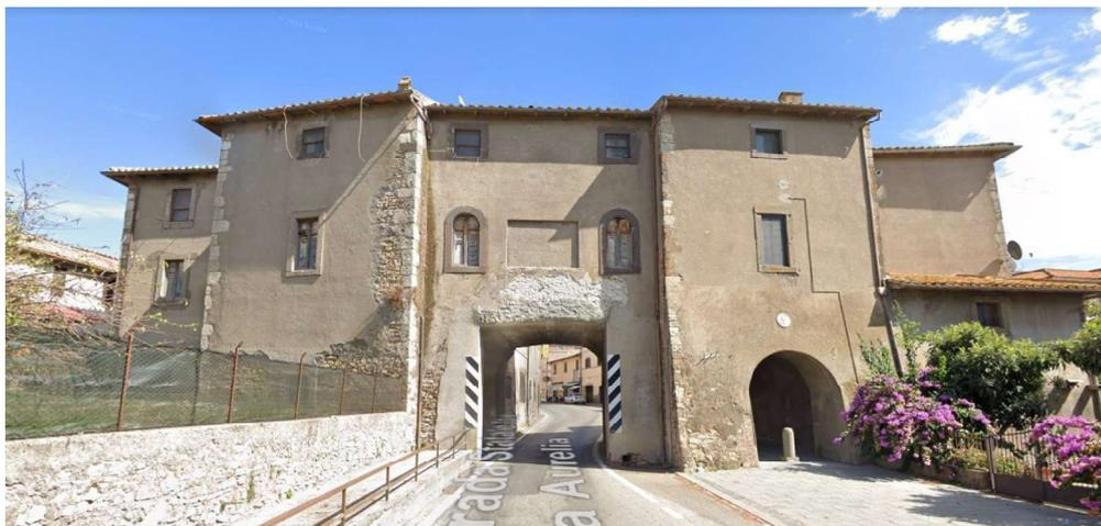
**Fig.2** strettoia del tracciato storico della S.S.1-bis in corrispondenza dell'ingresso ovest di Monteromano, percorsa a senso unico alternato da circa 7000 veicoli al giorno, di cui 400 di traffico pesante
